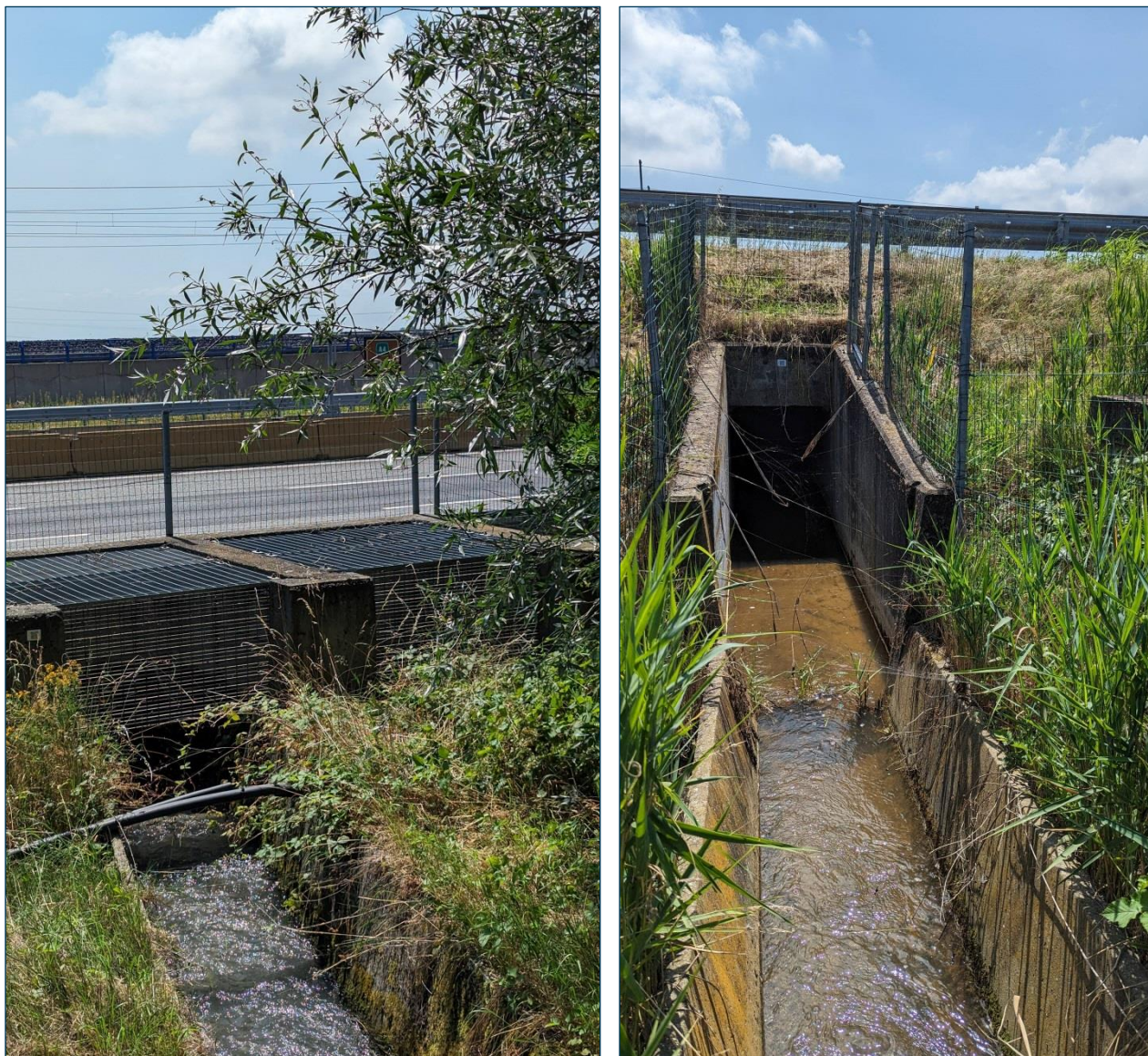
Figura 34. Esempi di tombini di attraversamento (autostrada).
