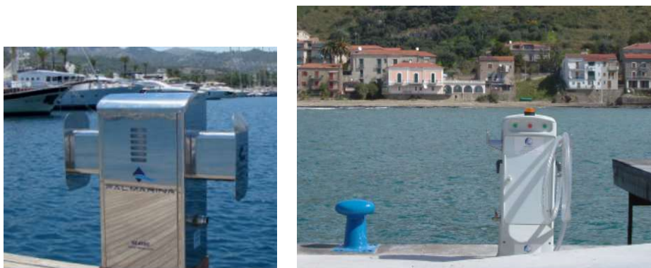
Figura 5-1 Esempi di colonnine per l'aspirazione dei rifiuti liquidi
