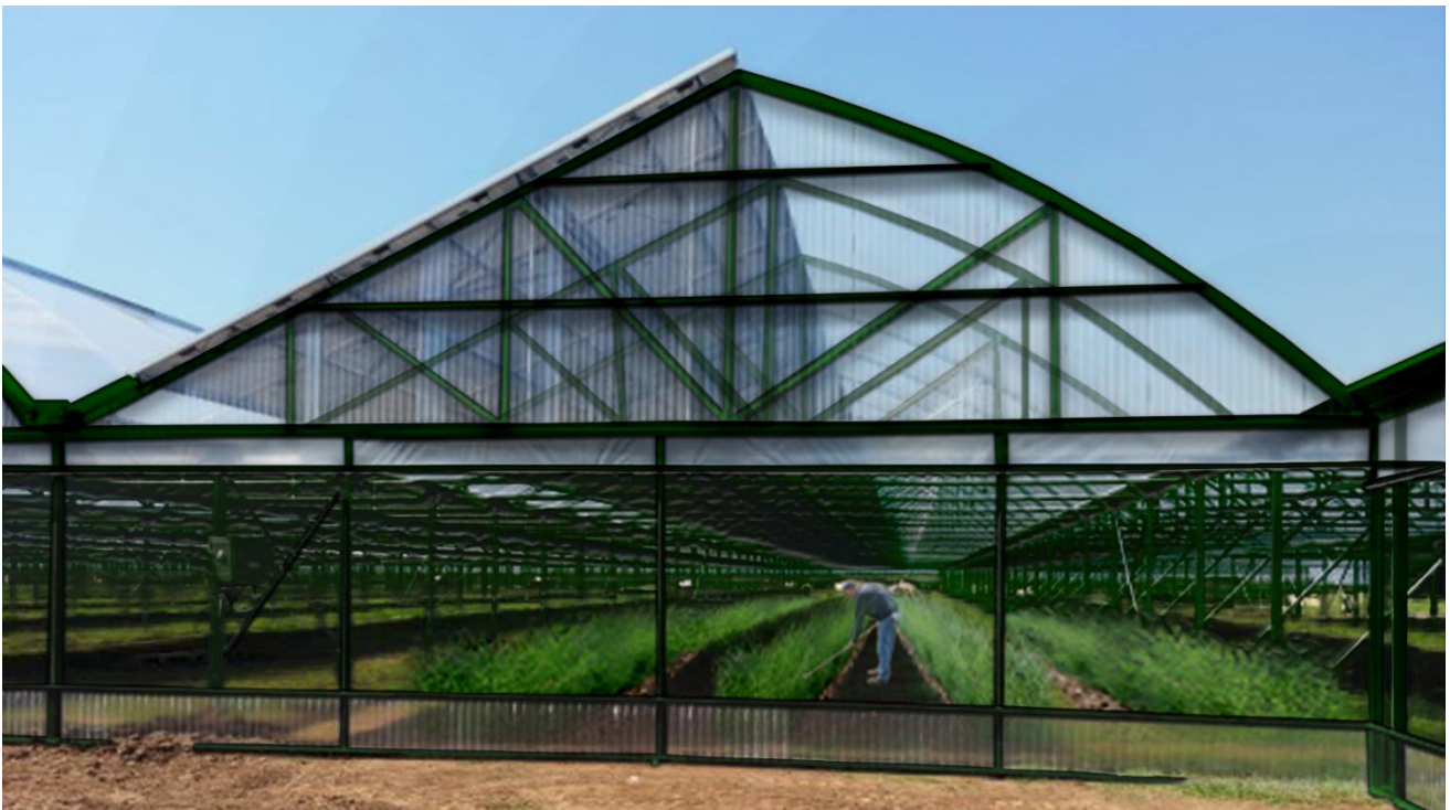
Figura 8 – Vista frontale della struttura serra coltiva
