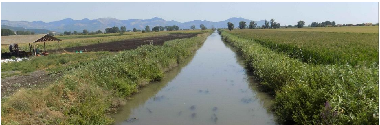
6_ "Canale della Selcella" (incrocio con via Migliara 47) Foto dello stato di fatto
