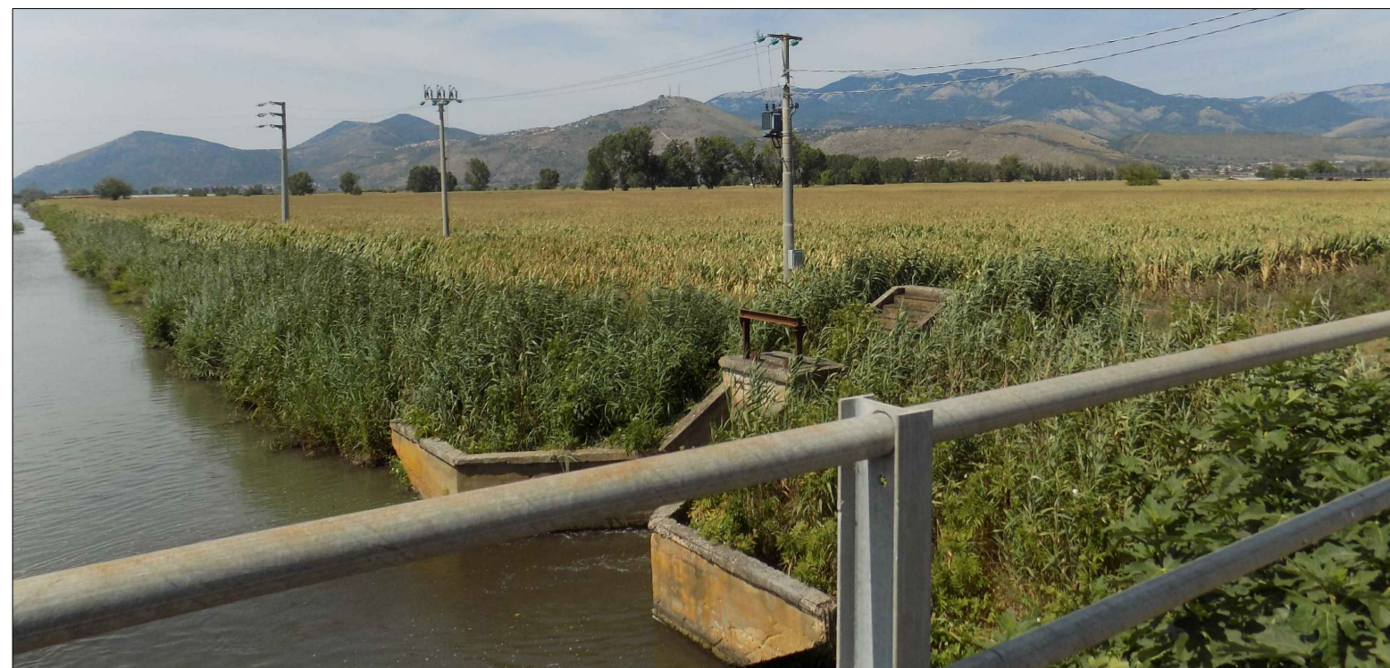
1_ "Canale della Selcella" (incrocio con via Migliara 48 sx)_ Foto dello stato di fatto
