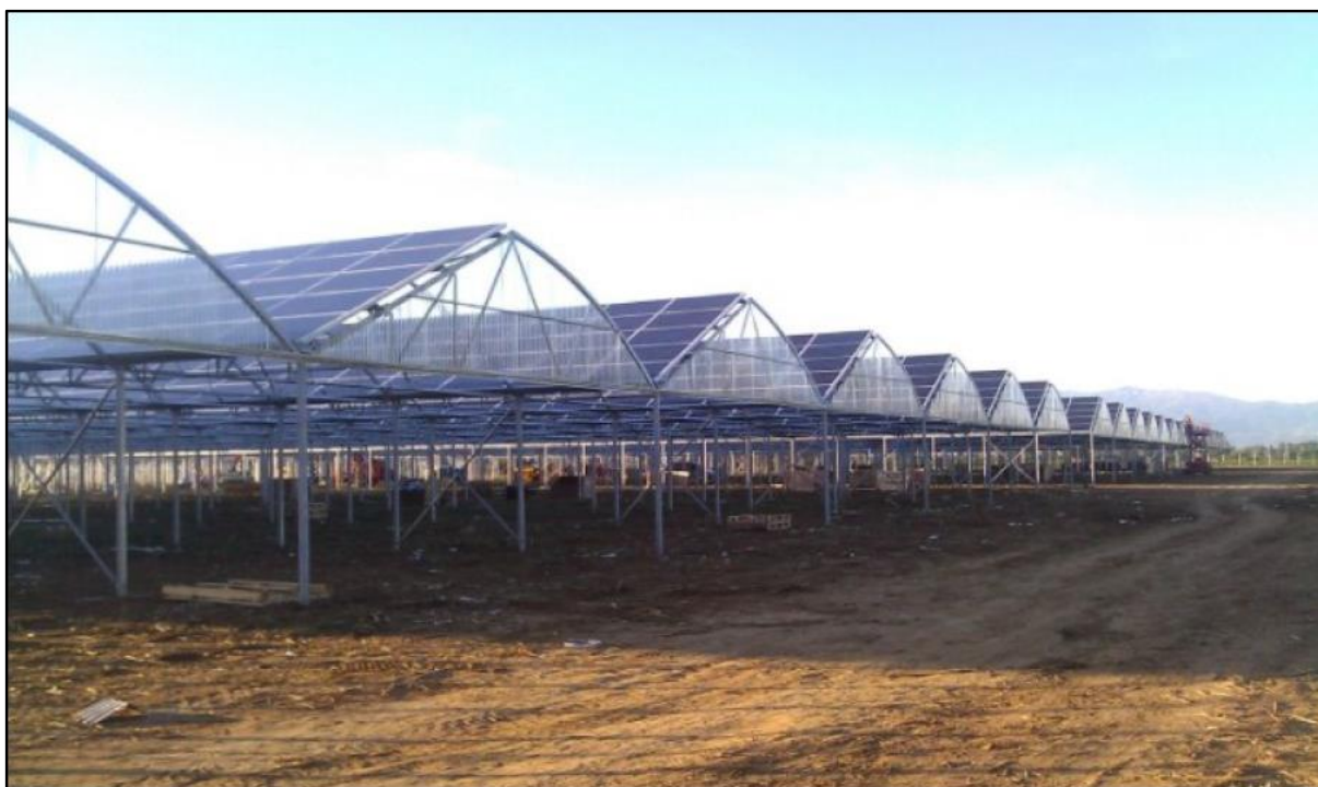
Figura 29 Schema configurazione progetto agri voltaico con pannelli montati su serre
