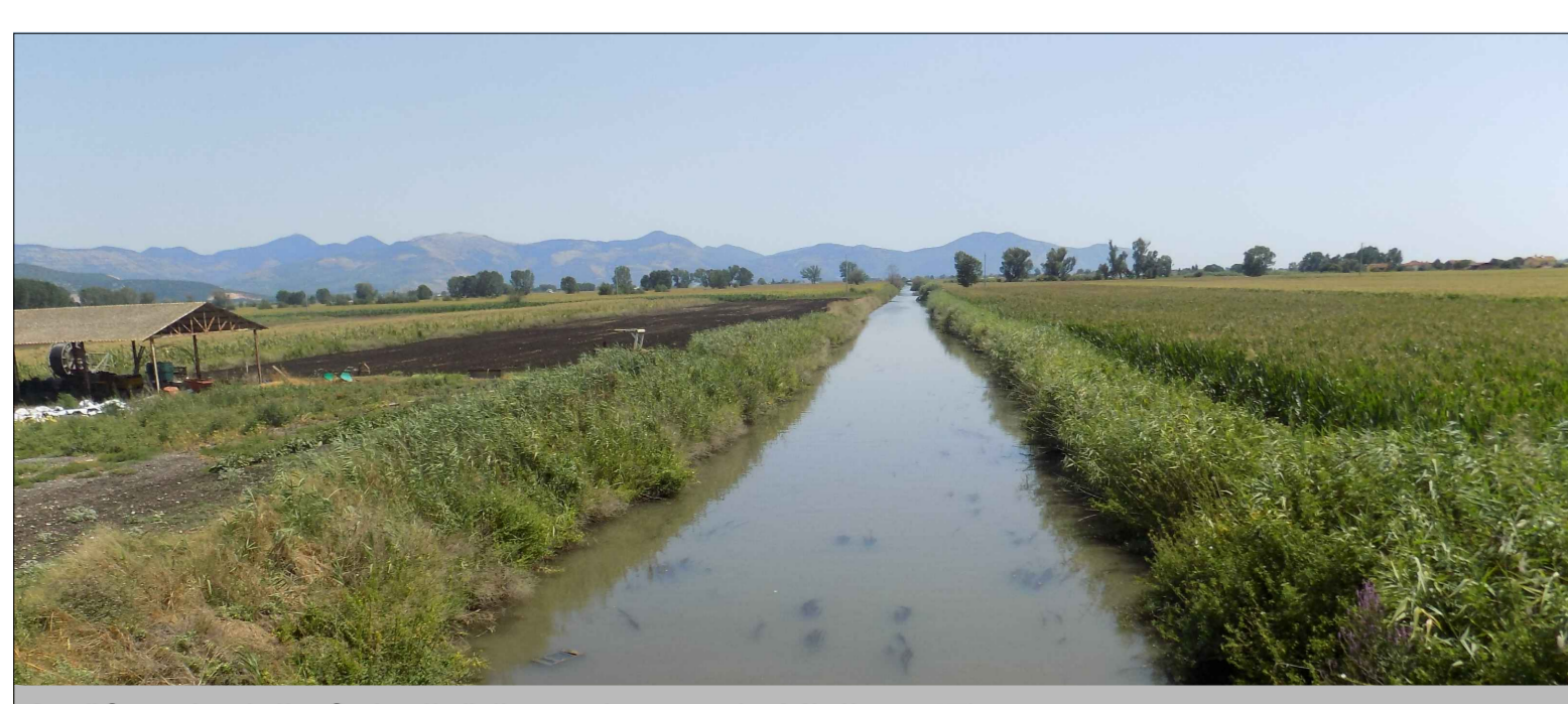
6_ "Canale della Selcella" (incrocio con via Migliara 47)_ Foto dello stato di fatto
