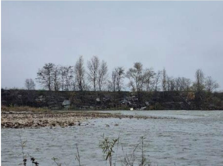
Figura 37 - Tratto di intervento dove si prevede la realizzazione della scogliera in massi ciclopici: è evidente che si tratta del ripristino di una preesistente difesa.
