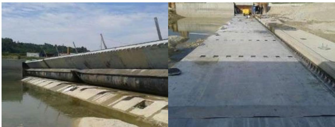
*Figura 5 – Sbarramento gonfiabile scudato con singolo elemento elastomerico di gonfiaggio a valle di*
