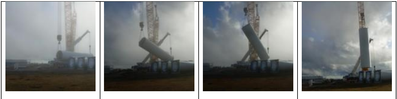
Figura 5.12 – Schema delle fasi di sollevamento dei componenti dell'aerogeneratore (Fonte sito web http://www.windfarmbop.com/ )
