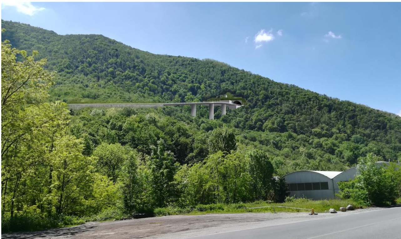
Progetto esecutivo: vista dell'Imbocco Nord (lato Lumezzane) della galleria naturale Villa Carcina con relativi manufatti tecnici.
