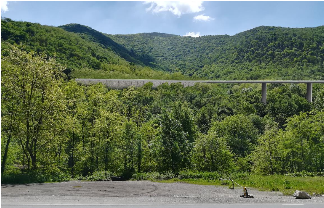
Vista del viadotto B del tratto stradale della Valgobbia.
