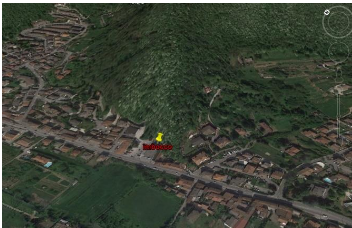
Figura 1.1: Area di intervento presso imbocco di Codolazza
