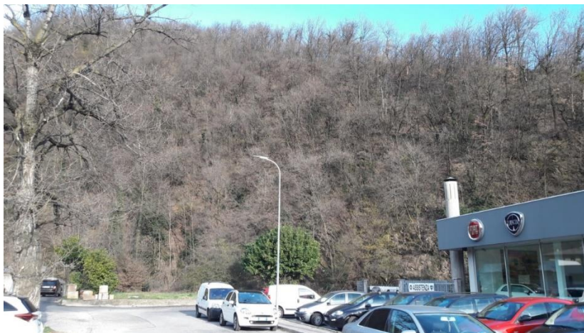
Figura 2.4: Condizioni attuali del versante dell'imbocco di Codolazza
