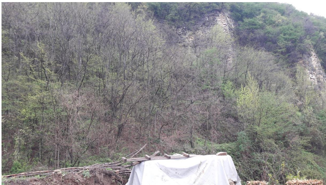
Figura 3.4: Condizioni attuali del versante dell'imbocco di Sarezzo
