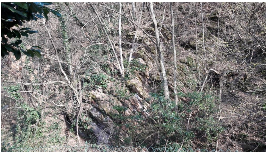
Figura 2.15: Affioramento strati della formazione 'Rosso ad Aptici' sul versante di imbocco galleria
