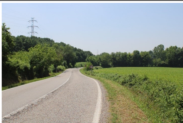
Tralicci dell'elettrodotto visti dalla SP19 (foto Ambiente Italia)
