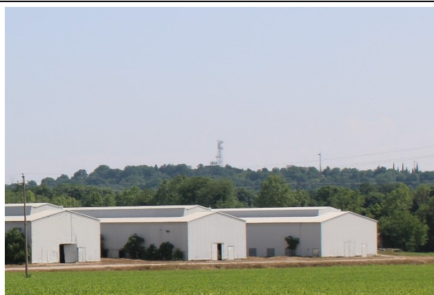
Traliccio della stazione radio base visto dall'area dell'allevamento abbandonato (foto Ambiente Italia)
