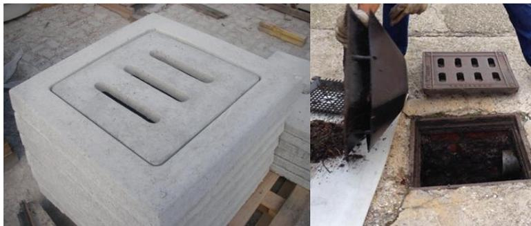
**Figura 5. 2** Pozzetti di grigliatura
