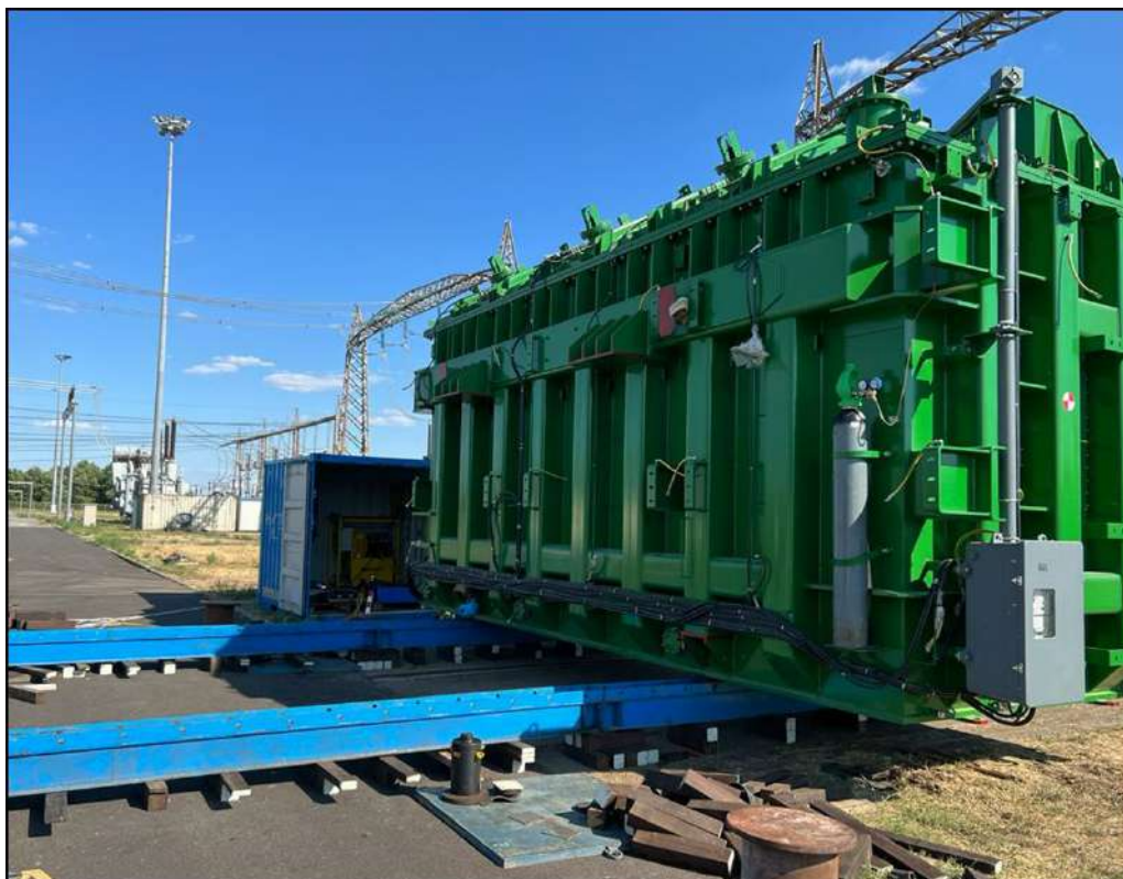
Scarico con Jack and Skidding
