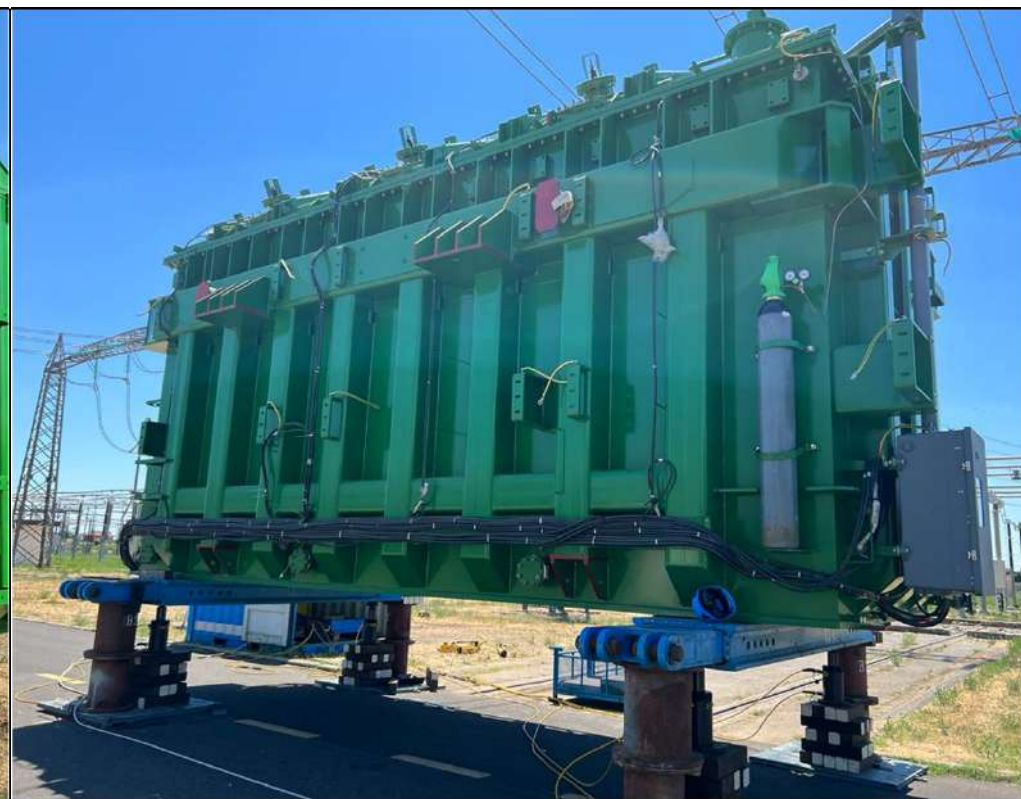
Scarico con Jack and Skidding
