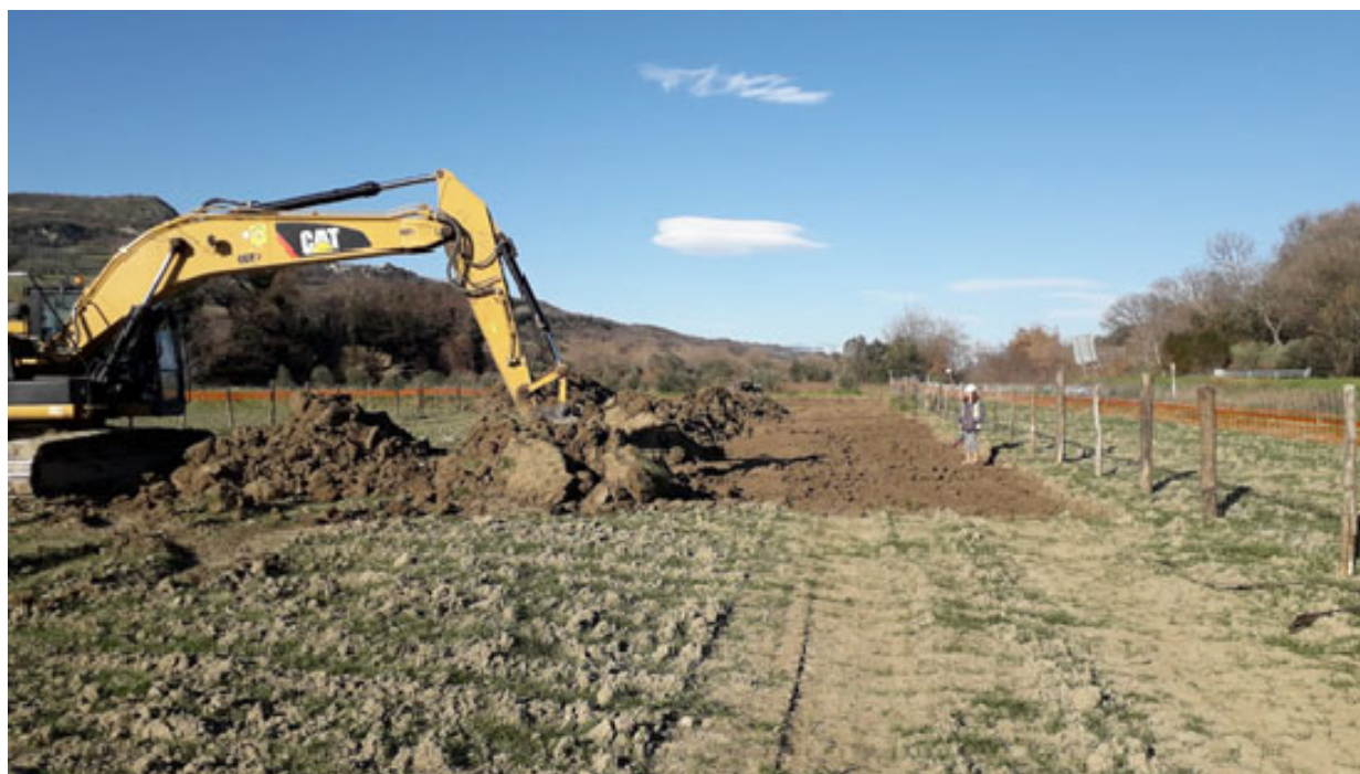
Fig. 2.2/A: Apertura pista di lavoro con accantonamento (a sinistra) dello strato superficiale di terreno (humus)
