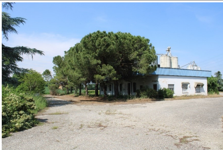
Conifere presenti nell'area verde di arredo presso l'ingresso e la zona dei silos (foto di Ambiente Italia)
