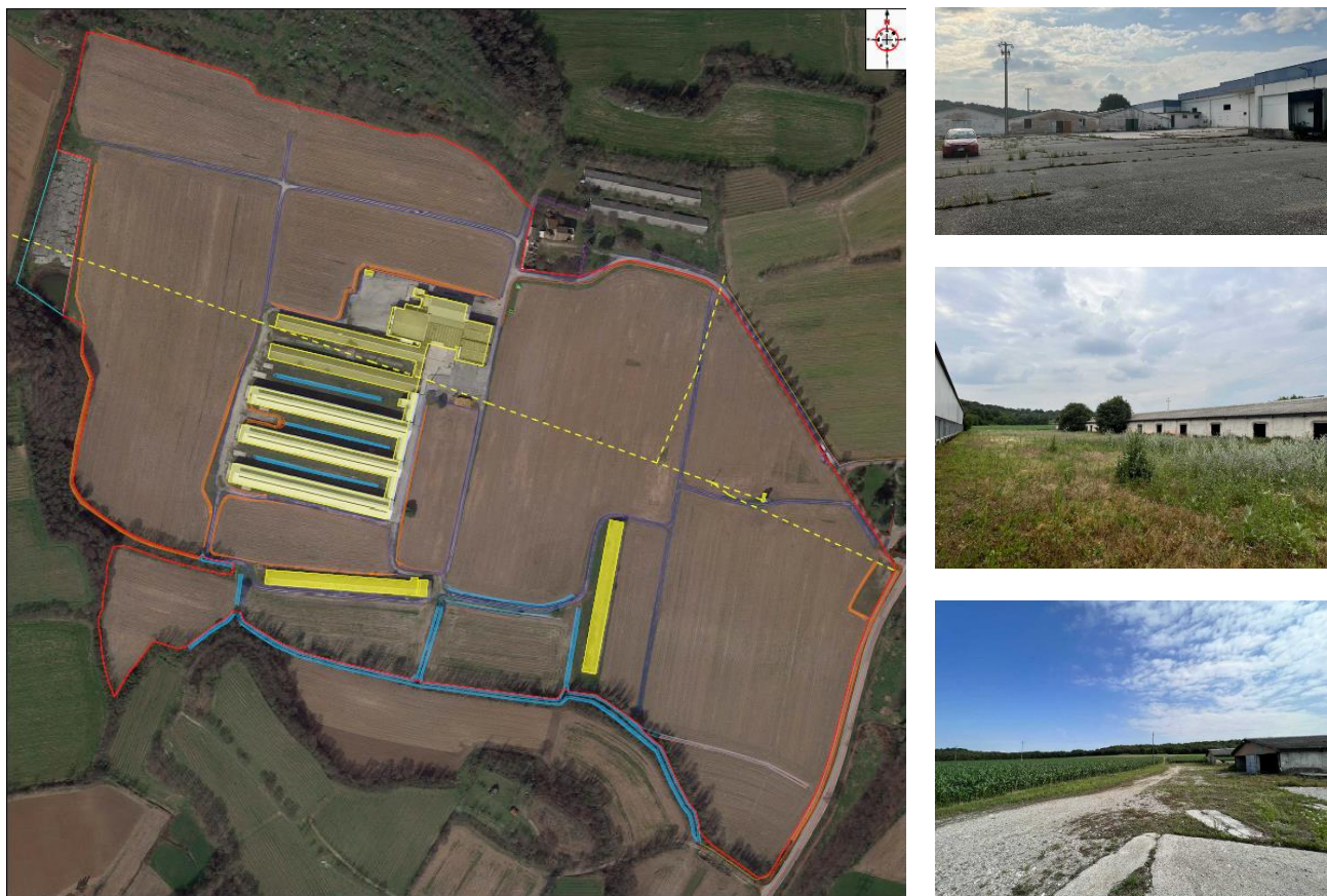
Figura 2.5 Ortofoto dell'area di progetto con individuazione dei fabbricati oggetto di demolizione (in giallo) e relativa documentazione fotografica
