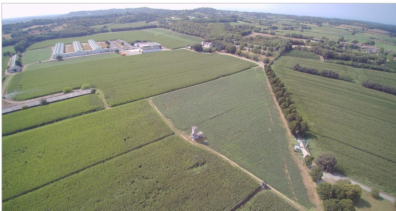
Figura 2.4 Visuale dell'area oggetto di intervento in direzione Nord
