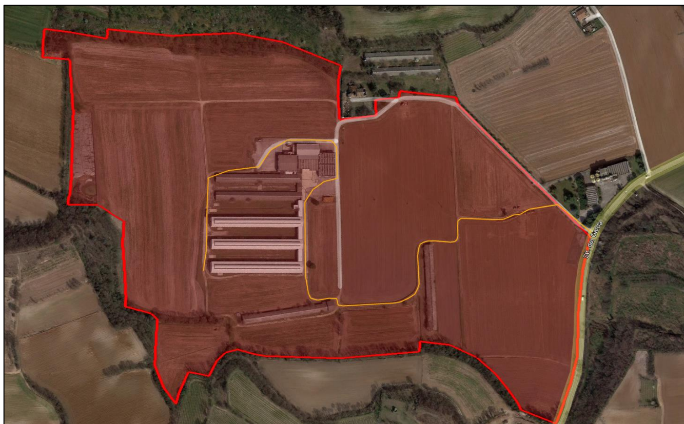
Figura 4.1 Percorso dei mezzi per il carico del materiale demolito (in giallo) all'interno dell'area del cantiere (in rosso)
