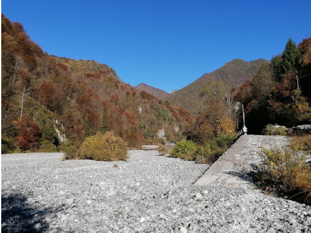
Foto 5 Area di cantiere di monte: la strada di cantiere che conduce verso la diga verrà realizzata sulle aree detritiche di deposito alluvionale, colonizzate in parte da arbusti di salice rosso, salice eleagno e poca Buddleya davidii verso le sponde; la vegetazione arbustiva non costituisce bosco ai sensi di legge (febbraio 2022)
