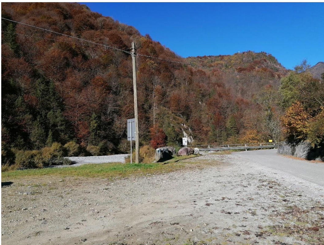
Foto 4 Area di cantiere di monte: l'accesso del cantiere e della strada di accesso per i lavori da realizzare a monte della diga è ubicato nei pressi del piazzale/parcheggio vicino al lago (febbraio 2022)
