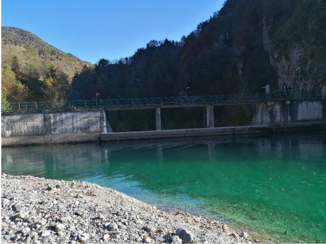
Foto 2 vista da monte della diga (febbraio 2022)
