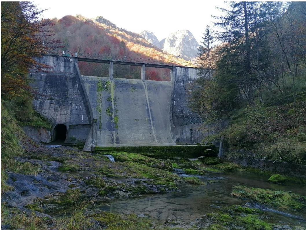
Foto 1 vista della diga di Cassiglio: costruita nel 1951-1952 necessita ora di interventi di adeguamento statico e idraulico (febbraio 2022)
