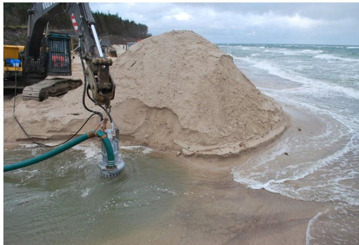
Figura 4 Pompa di aspirazione collegata idraulicamente a braccio escavatore
