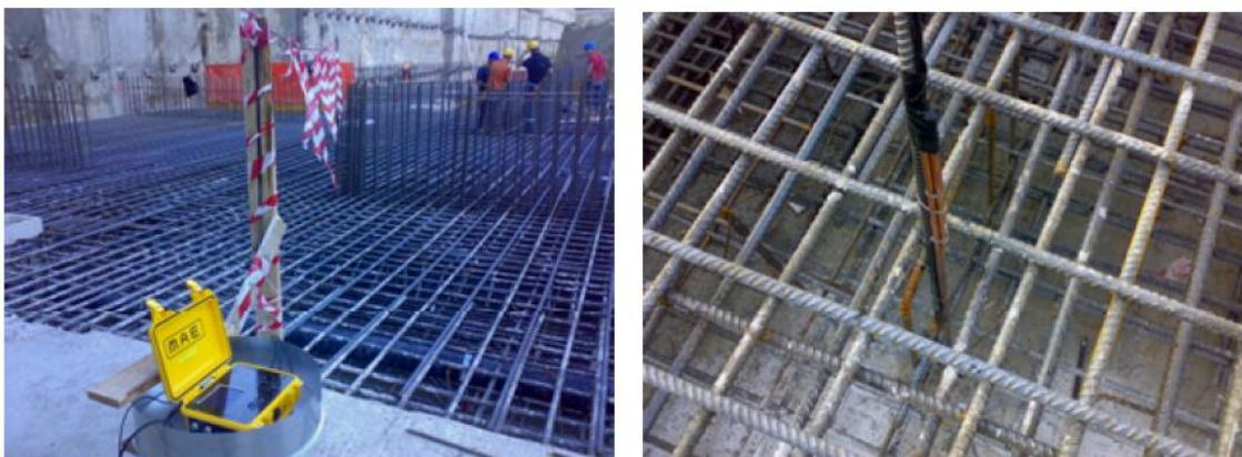
Figura 5.1 – Centralina registrazione e controllo dei termometri (a sx); configurazione termometri (a dx).
