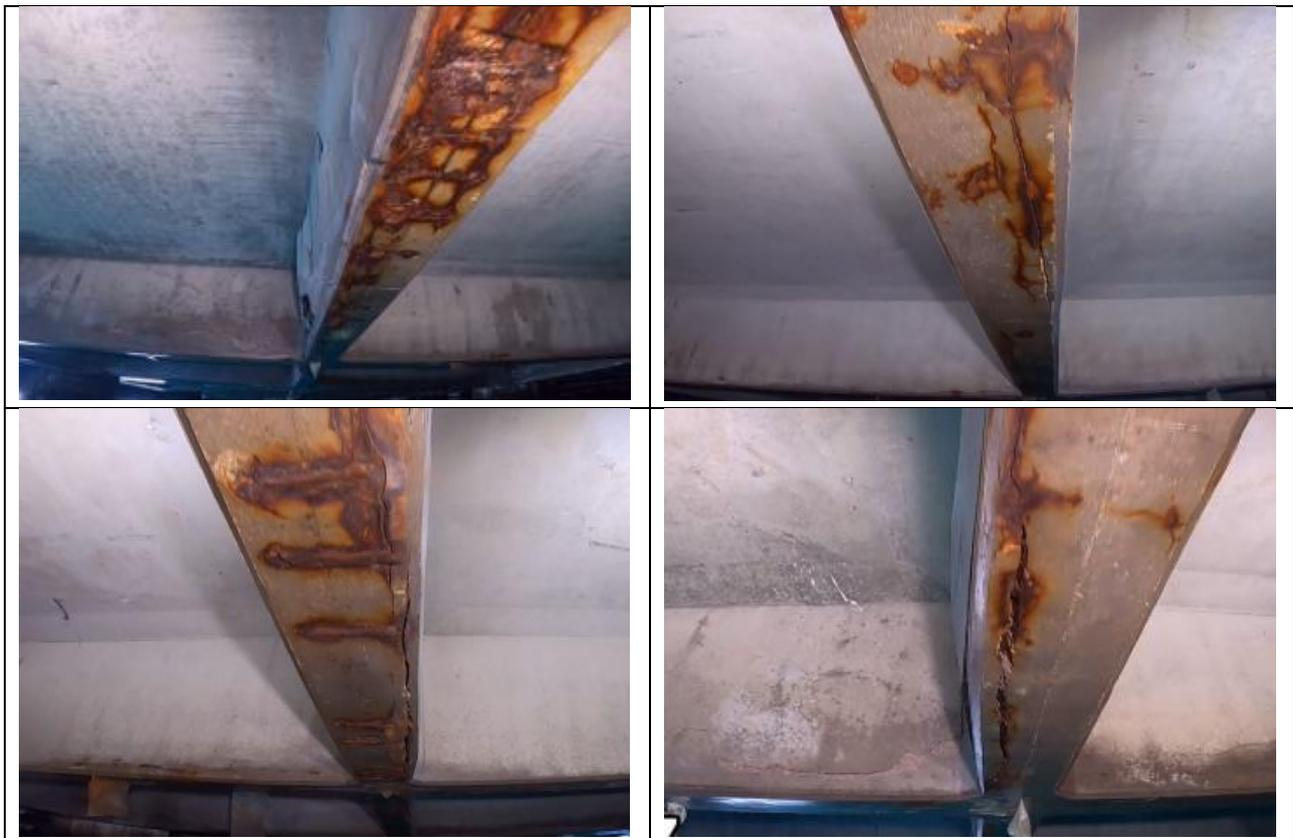
Figura 8.3: Esempi tipici di fessurazioni con copriferro che impedisce di rilevare l'entità del degrado
