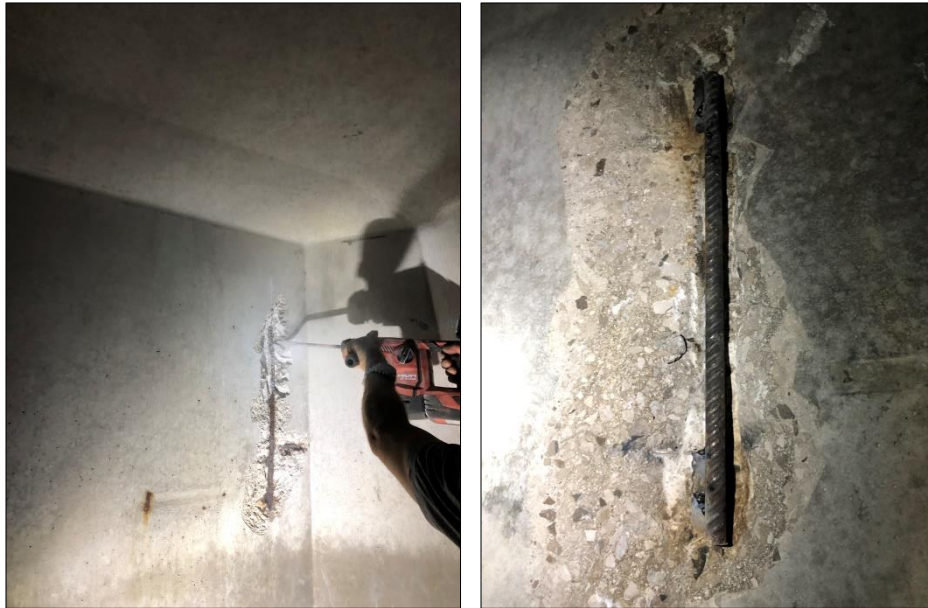
Alcune fasi del prelievo spezzone barra di armatura e ripristino.
