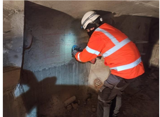
Prima fase di smerigliatura con disco smeriglio
