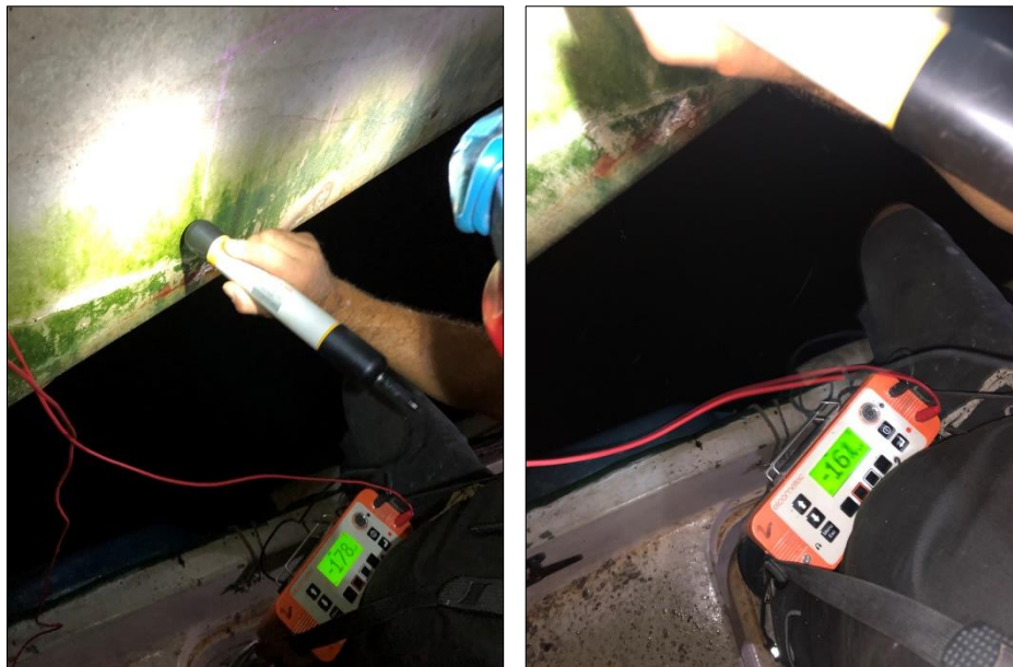
Misurazione del potenziale di corrosione.
