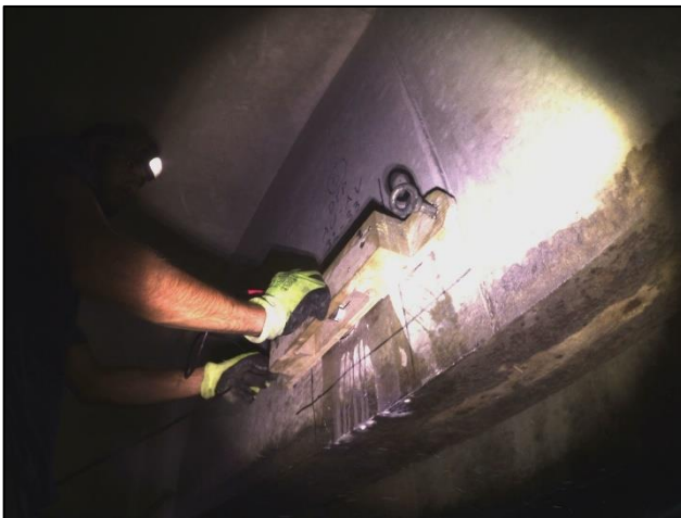
Alcune fasi della prova di detensionamento 5
