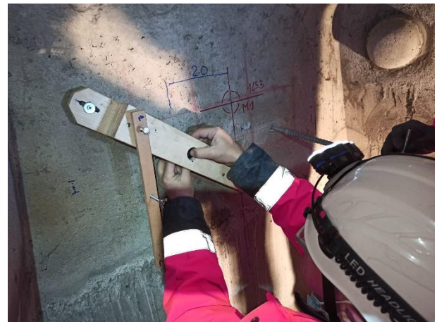
Messa in opera della rosetta mediante apposito sistema di fissaggio
