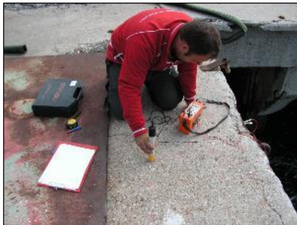
Misura del potenziale di corrosione.
