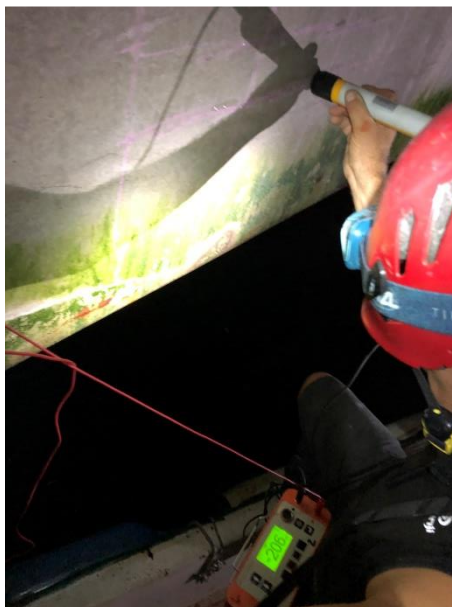
Misurazione del potenziale di corrosione.
