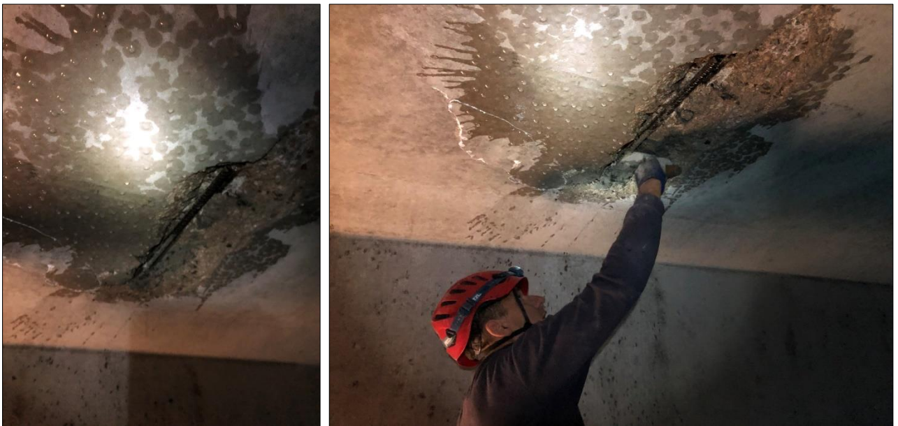
Alcune fasi del prelievo spezzone barra di armatura e successivo ripristino.
