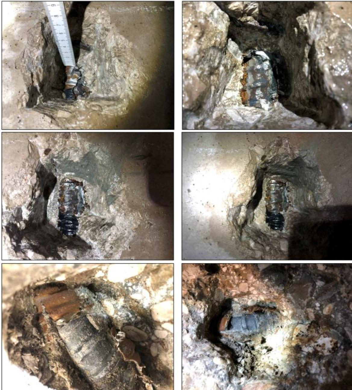
Figura 4.2 – Immagini relative alle ispezioni alle barre di precompressione (indagini INSITU 2020).
