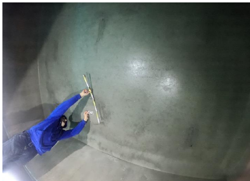
Figura 2.3 – Ispezione dell'intradosso delle solette dell'impalcato.
