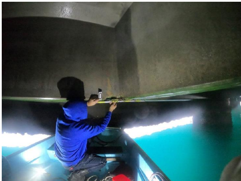
Figura 2.2 – Ispezione dell'intradosso delle travi portanti dell'impalcato.
