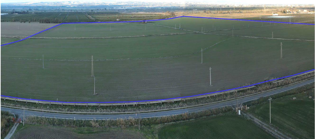
(Vista panoramica dell'area disponibile – Area nord)
