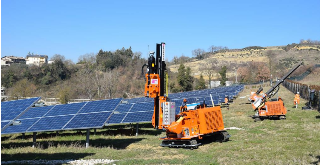
(Esempio di installazione di pali di fondazione mediante battipalo; tratto da Pauselli Group, sito web)
