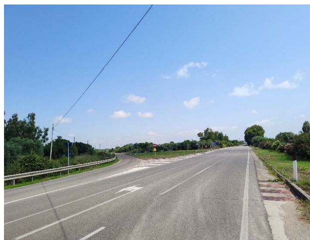
Figura 5 – tratto della SS 126 interessato dall'elettrodotto interrato.
