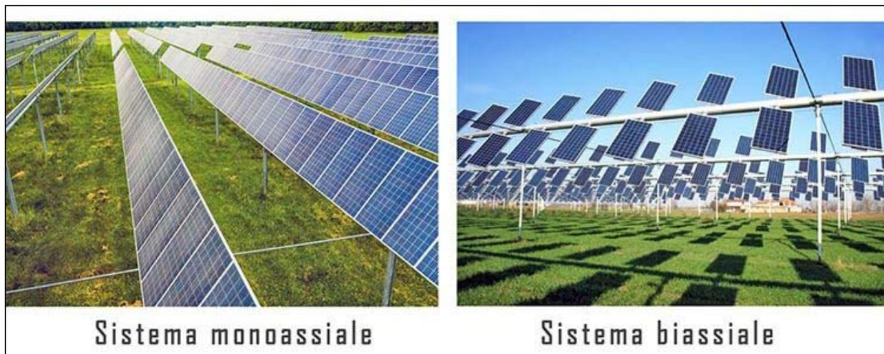
Figura 9. Sistema mono e biassiale. <https://www.infobuildenergia.it/approfondimenti/agrivoltaico>
