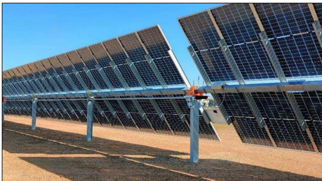
Figura 2 - Esempio di struttura a tracker mono-assiale
