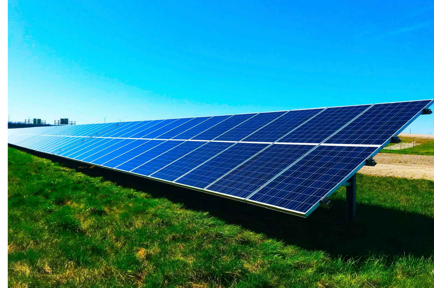
Esempio di sviluppo stringa con tracker 2P
