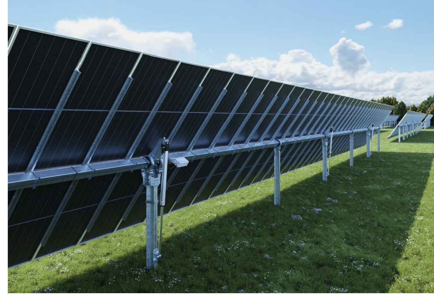
Esempio di sviluppo stringa con tracker 2P
