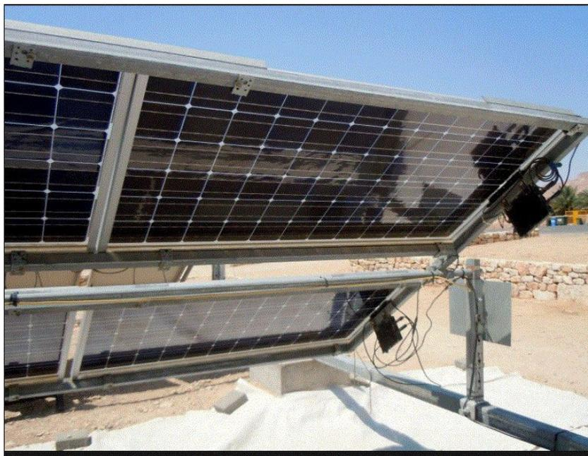
*Fig. 5.1-1 Tipico Modulo agrovoltaico Bifacciale*
