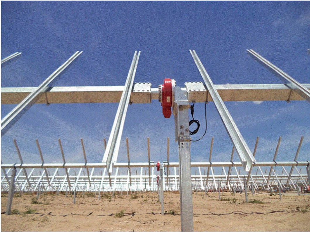
Fig. 5.4-2 Componenti struttura di supporto
