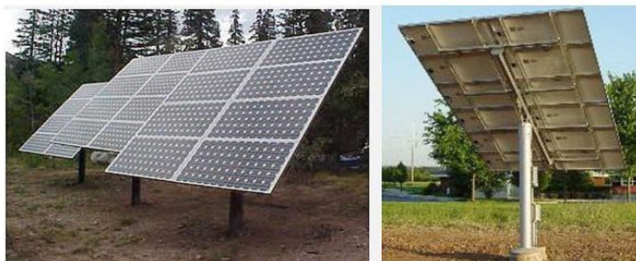
Figura 3.1-2 Inseguitori di Tilt
