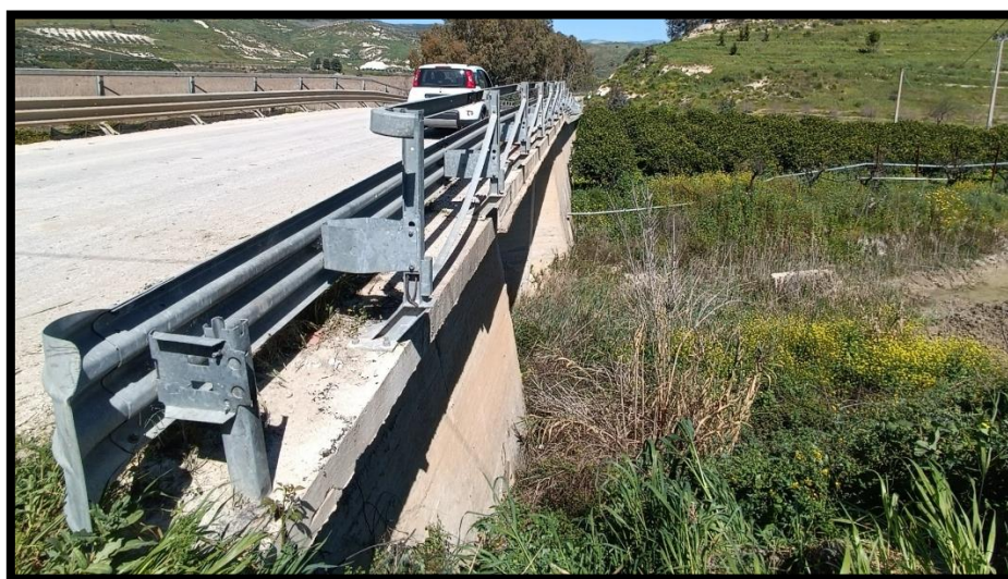
Figura 5 - foto dell'impluvio costituente l'interferenza "Int 5"
