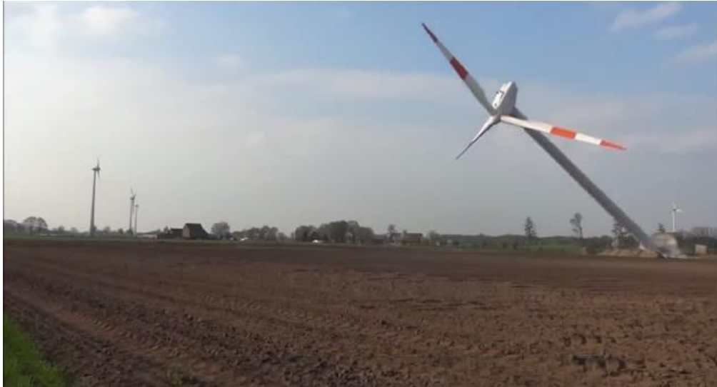
Figura 9- Ribaltamento della torre alla radice
