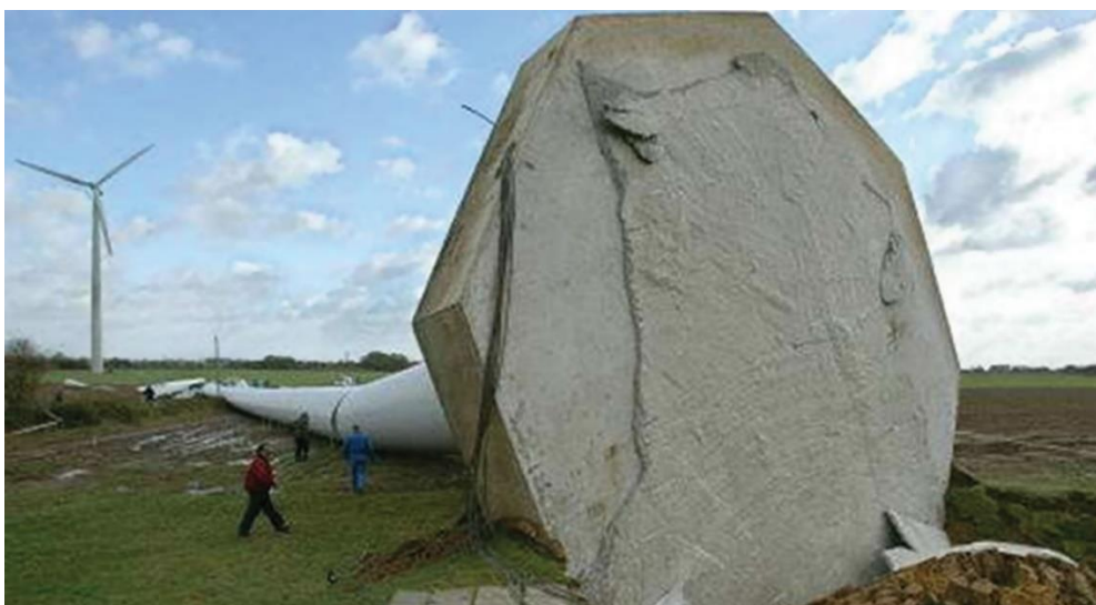
Figura 8- Ribaltamento della torre e del plinto
