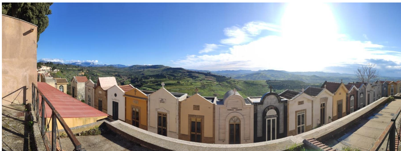
Figura 33 R08 – BENI ISOLATI – Cimitero di Ribera _ ANTE
