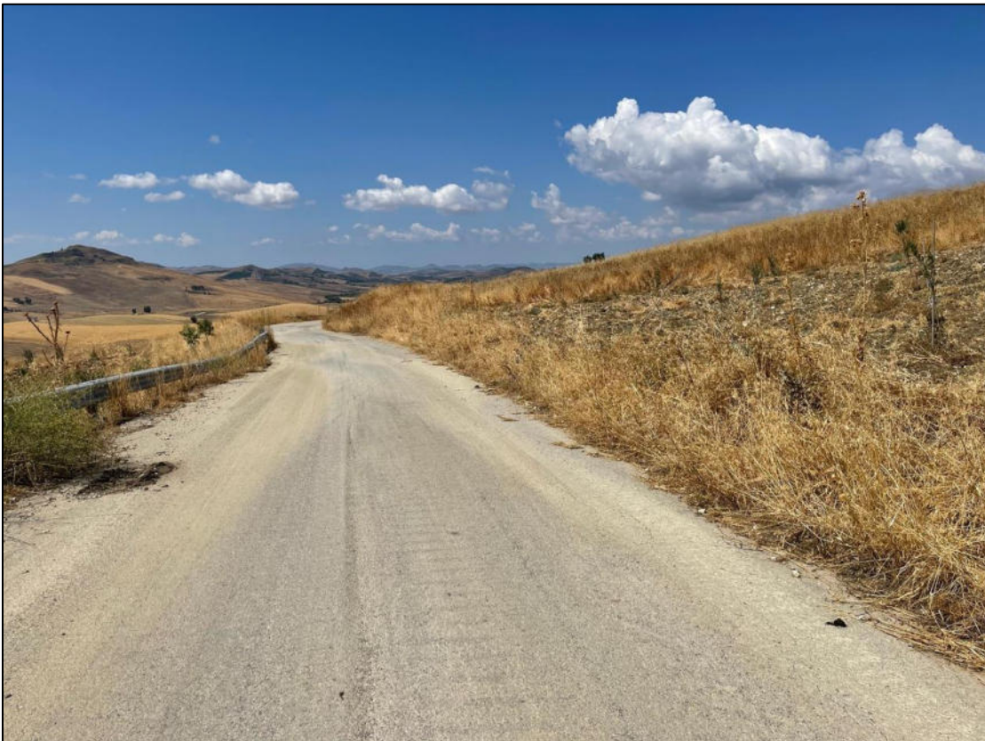
Foto 20 - Panoramica UR 03 (cavidotto interrato)
