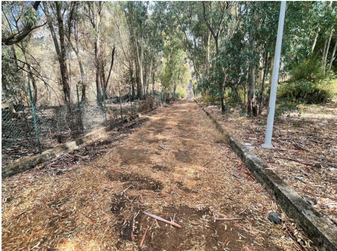
Foto 28 - Panoramica UR 04 (cavidotto interrato)
