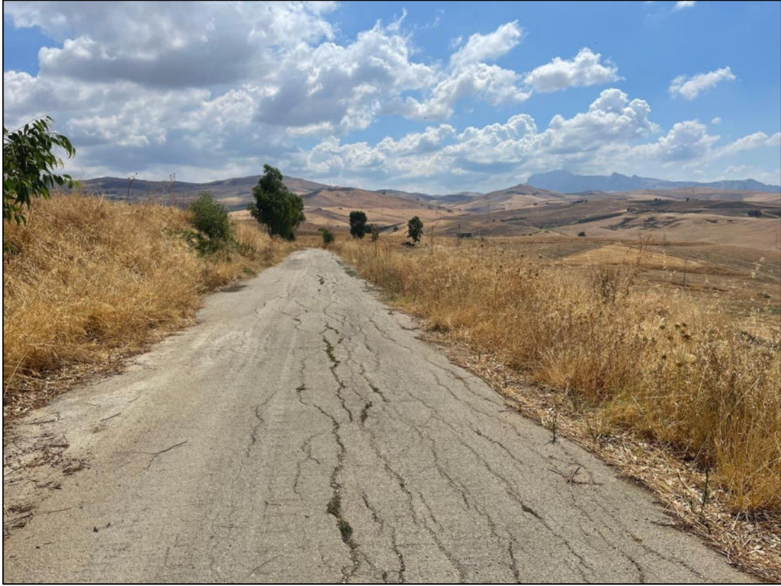
Foto 17 - Panoramica UR 03 (cavidotto interrato)
