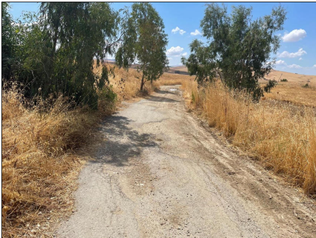
Foto 16 - Panoramica UR 03 (cavidotto interrato)
