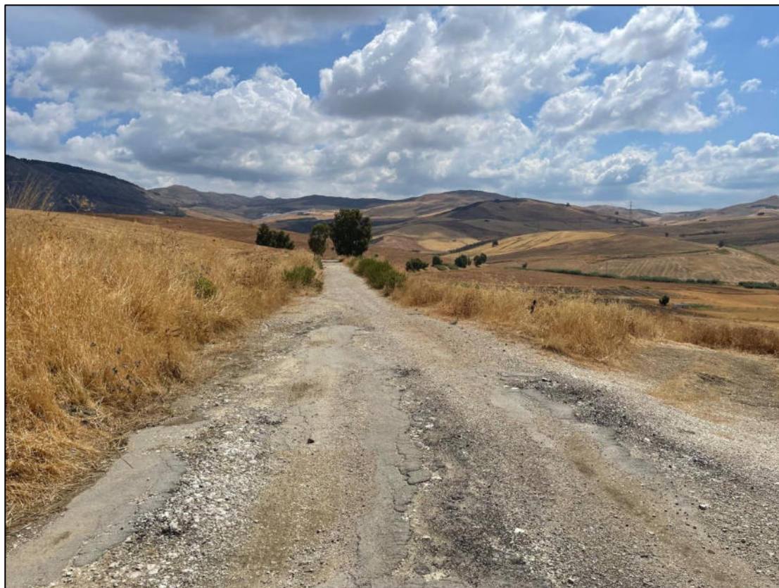
Foto 15 - Panoramica UR 03 (cavidotto interrato)
