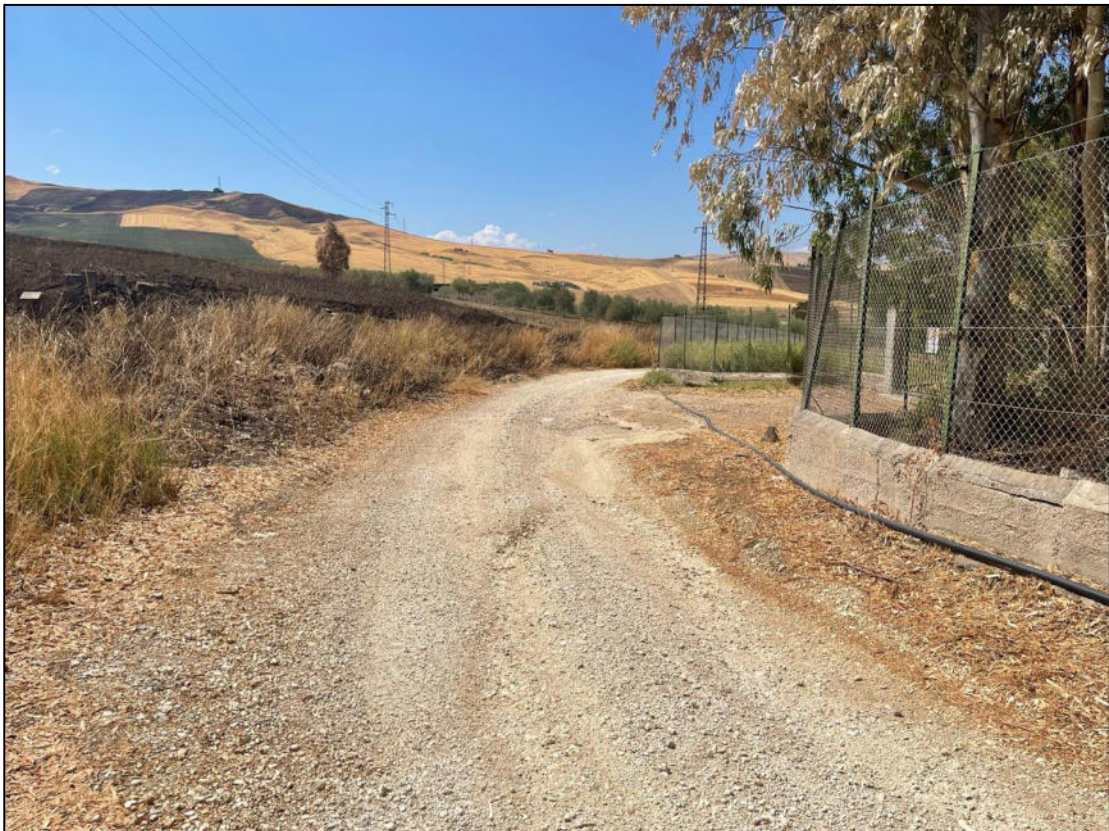
Foto 26 - Panoramica UR 04 (cavidotto interrato)
