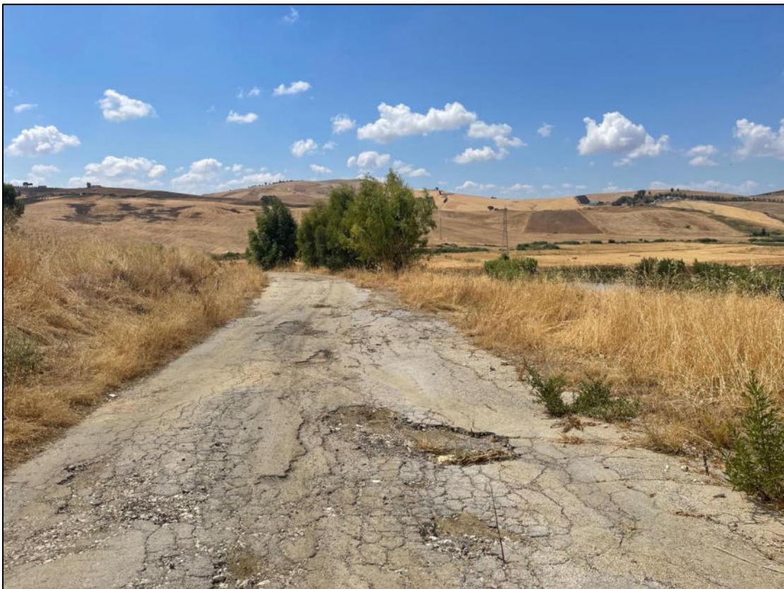
Foto 14 - Panoramica UR 03 (cavidotto interrato)
