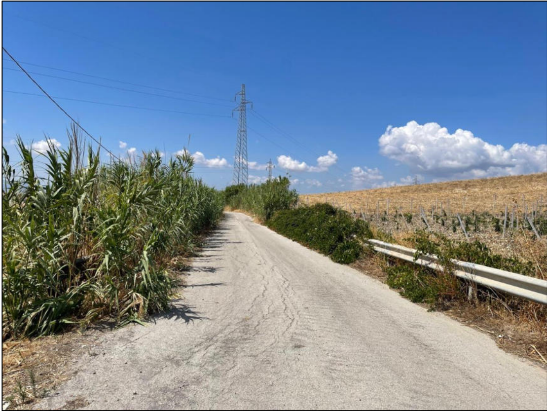
Foto 21 - Panoramica UR 03 (cavidotto interrato)
