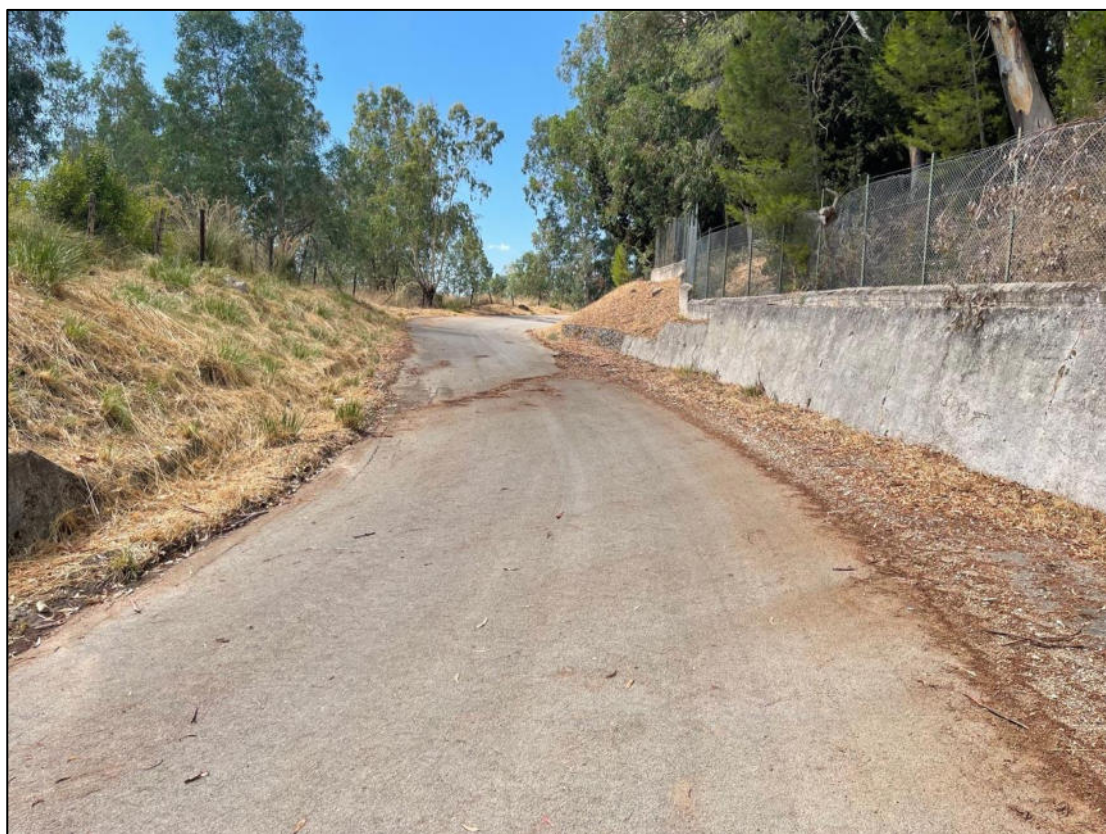
Foto 24 - Panoramica UR 03 (cavidotto interrato)
