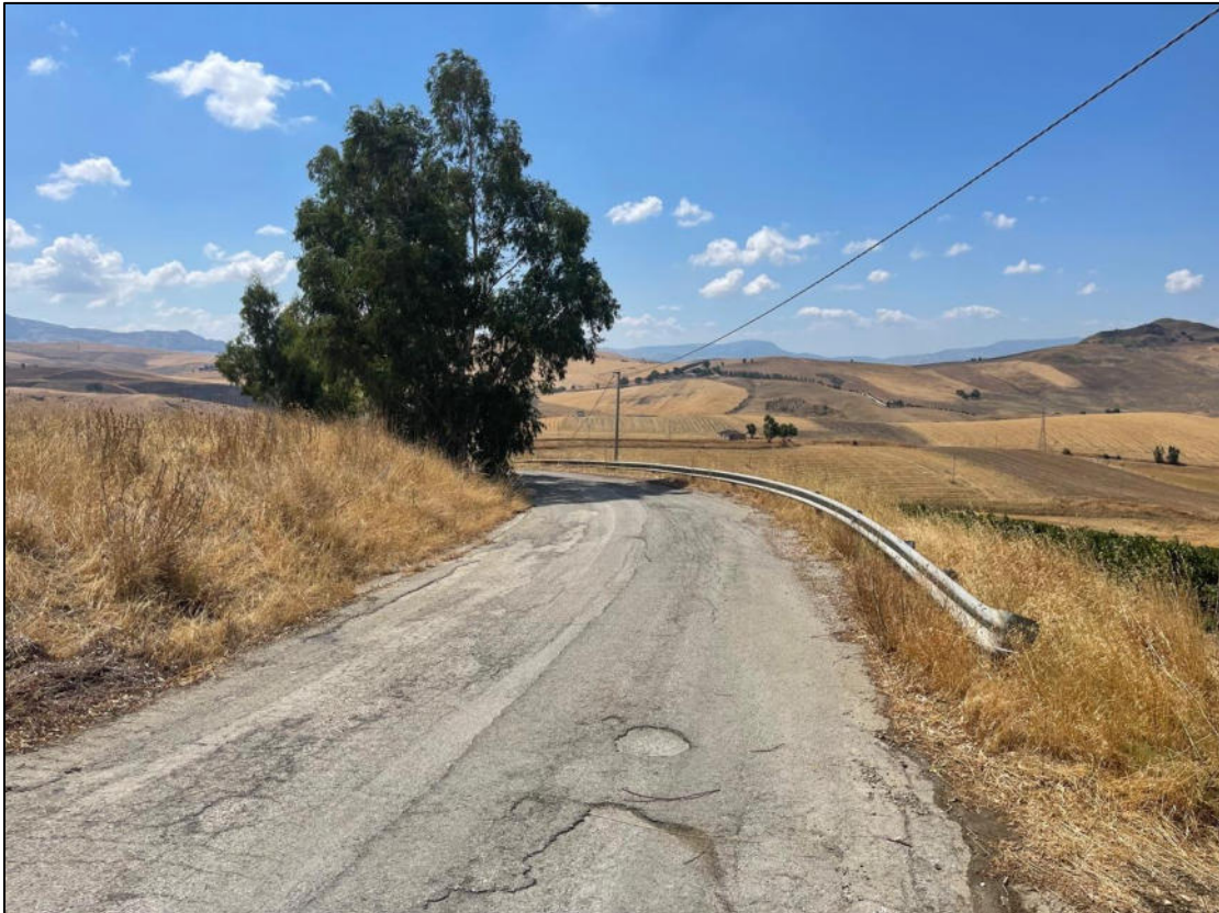
Foto 18 - Panoramica UR 03 (cavidotto interrato)
