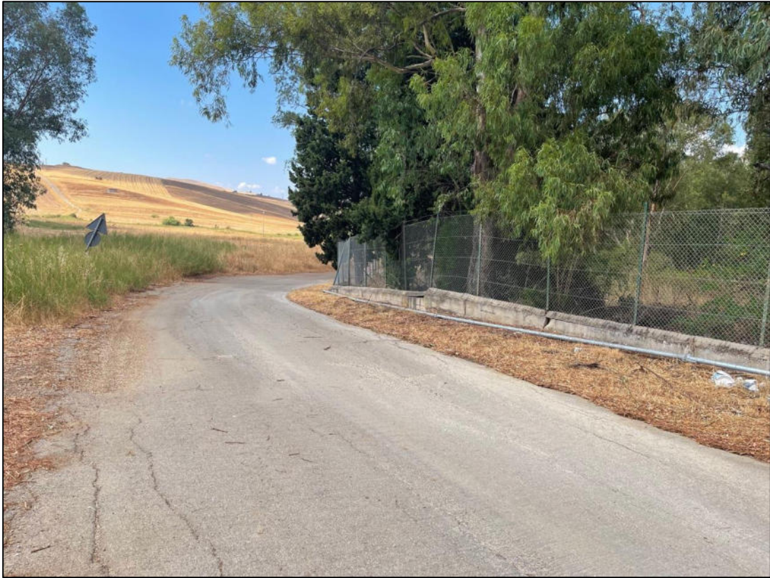
Foto 25 - Panoramica UR 03 (cavidotto interrato)
