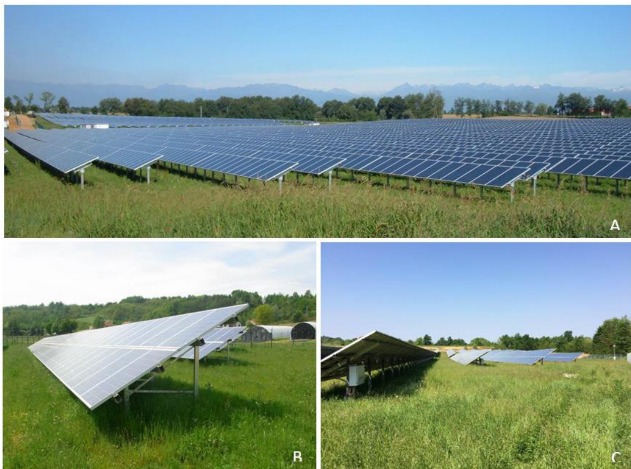
Figura 75. Immagini di grandi impianti fotovoltaici a terra (scattate dagli scriventi) riferite a progetti realizzati (anche con tecnologie differenti) che forniscono evidenza oggettiva dell’effetto non limitante dell’ombreggiamento generato per l’attività fotosintetica. A) Impianto FV “Ternavasso” – 7,5 MWp, Poirino (TO); B) Impianto FV “Cortiglione Green” – 0,8 MWp, Cortiglione (AT); C) Impianto FV “Sulpiano Cross” – 2,5 MWp, Montà (CN).
