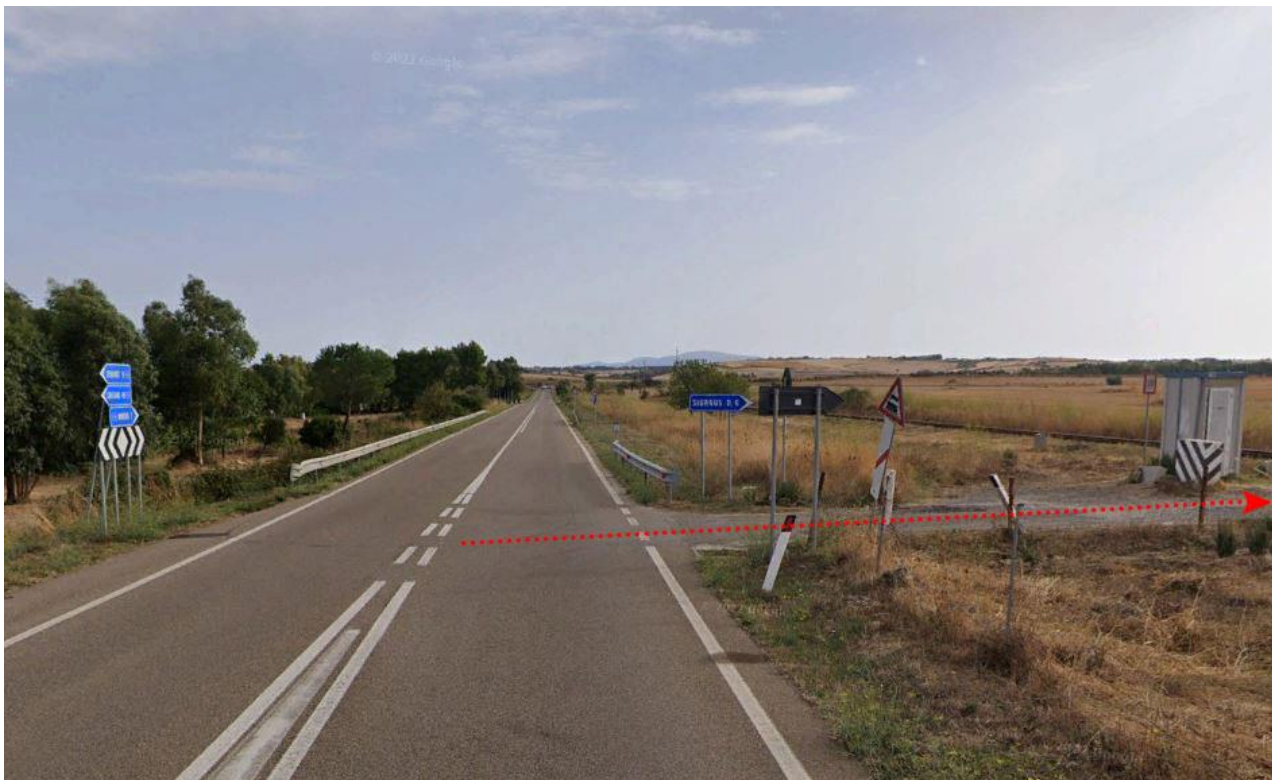
Figura 5.6 - Accesso al Cluster Est dalla S.S. 128 in località Pranu Trazzu (direzione nord)
