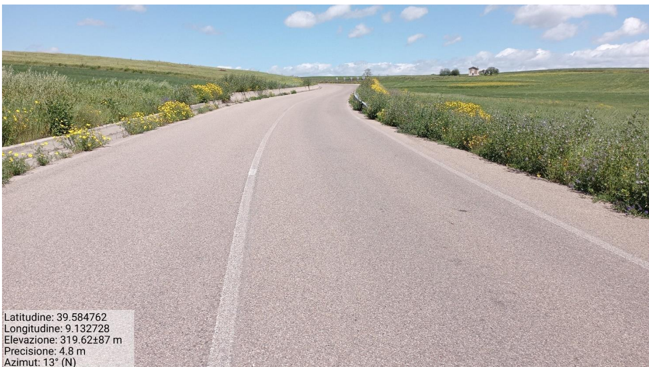
Figura 5.20 – Asse di accesso principale lungo il quale si innesta la viabilità di nuova costruzione di accesso alle postazioni AG05, AG06 e AG08 (direzione nord)
