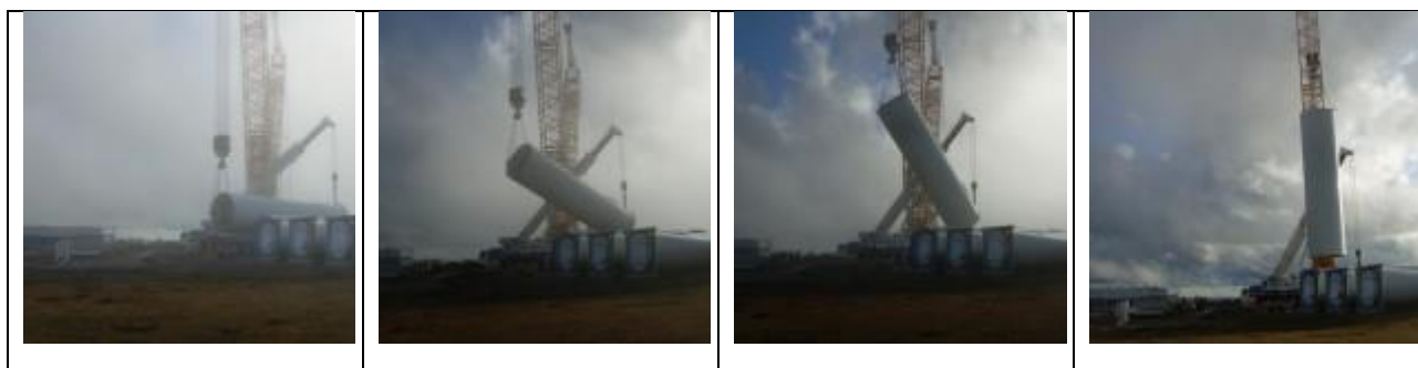
Figura 5.39 – Schema delle fasi di sollevamento dei componenti dell'aerogeneratore (Fonte sito web http://www.windfarmbop.com/ )
