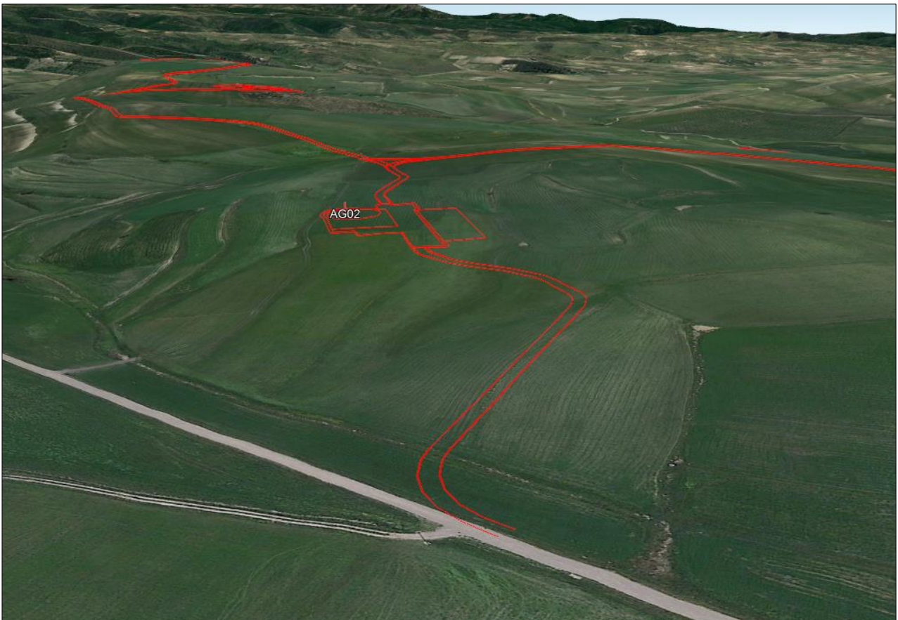
Figura 5.8 – Nuova viabilità di collegamento alla postazione eolica AG02 (vista prospettica da nord-est)
