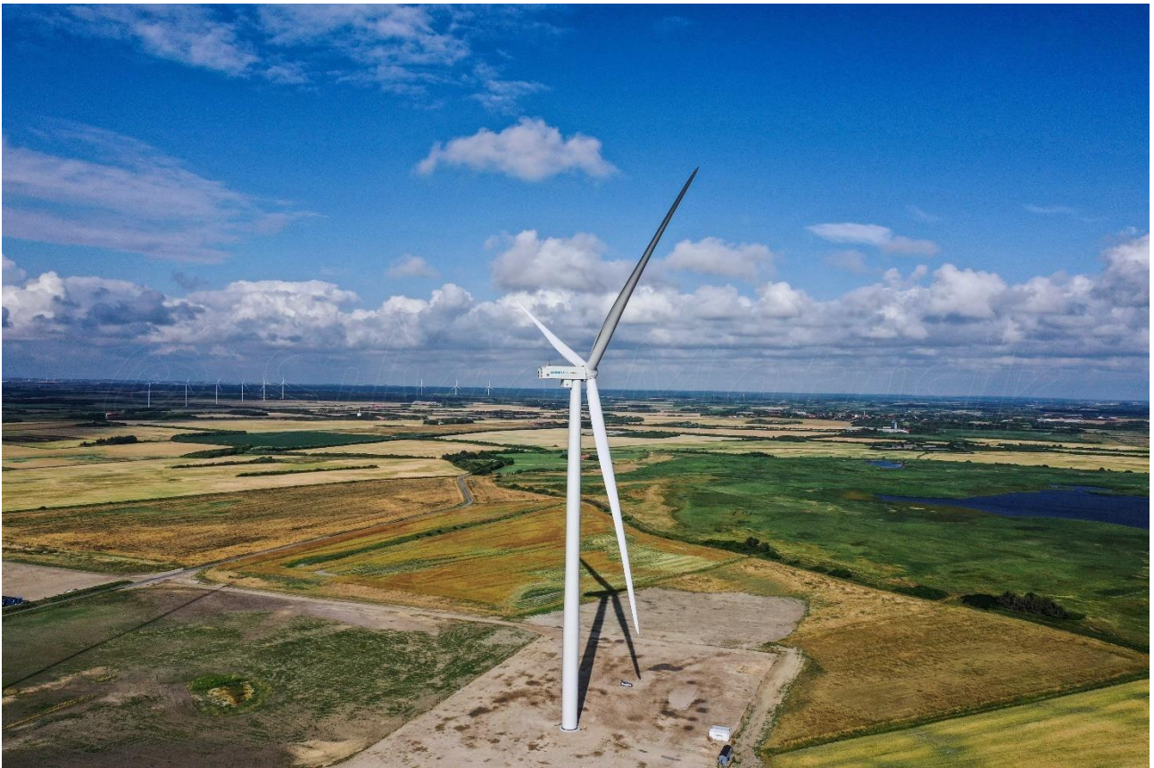
Figura 5.1 – Aerogeneratore Siemens-Gamesa tipo SG 6.0-170 M1
