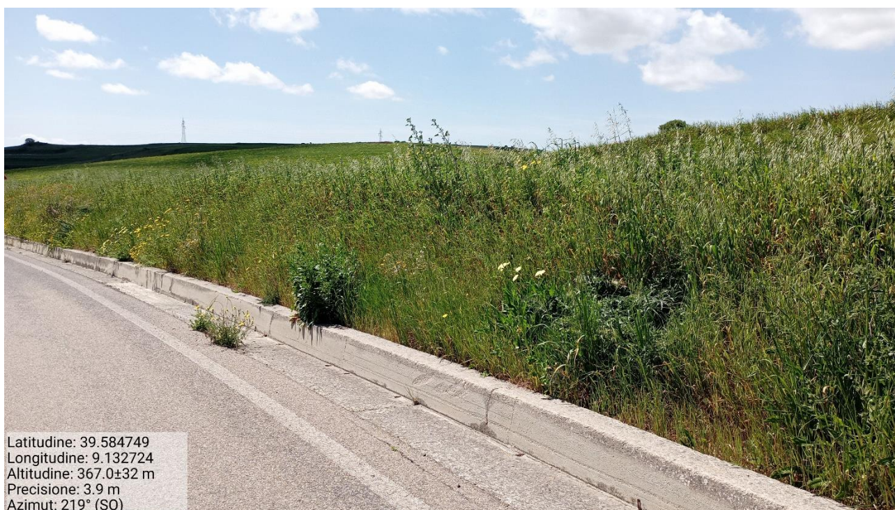
Figura 5.29 – Punto in cui si attesta la viabilità di nuova costruzione di accesso alla postazione AG06 (direzione sud - ovest)
