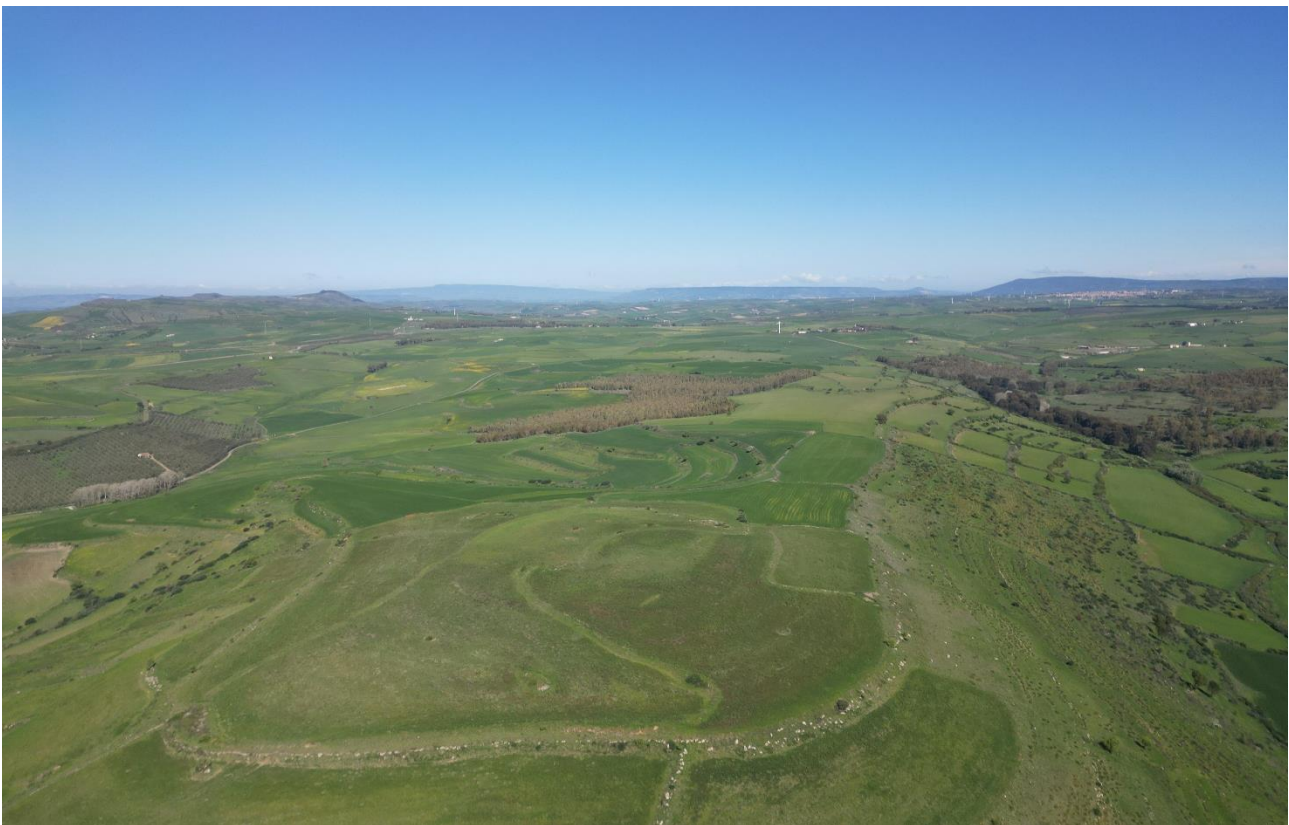
Figura 7.10 – Veduta sull'area di installazione della porzione nord-orientale dell'impianto. Ripresa aerea da sud-est verso nord-ovest nei pressi della postazione AG04
