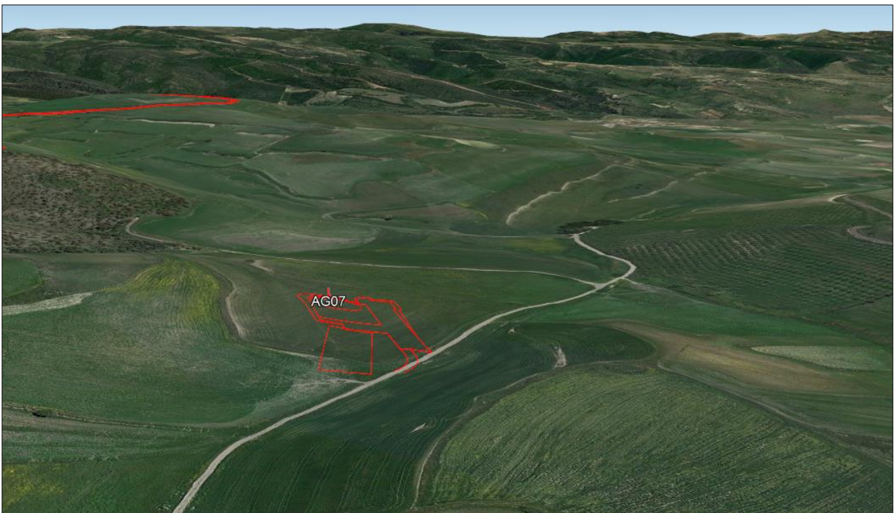
Figura 5.11 – Vista prospettica della viabilità rurale esistente e dell'asse di nuova realizzazione di accesso alla postazione eolica AG07 (vista da nord-ovest)
