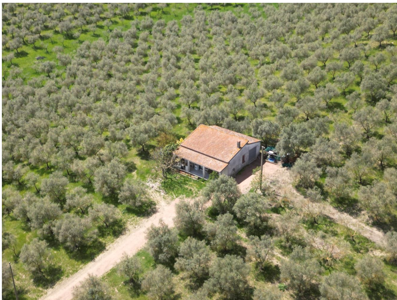
Figura 6.2 – Fabbricato F126 – Vista aerea da nordest. Si noti come il prospetto ovest (sul retro del fabbricato) risulti in sostanziale aderenza a un filare di ulivi in grado di esercitare un'efficace azione di schermo rispetto all'ombreggiamento intermittente ad opera dell'aerogeneratore AG05.
