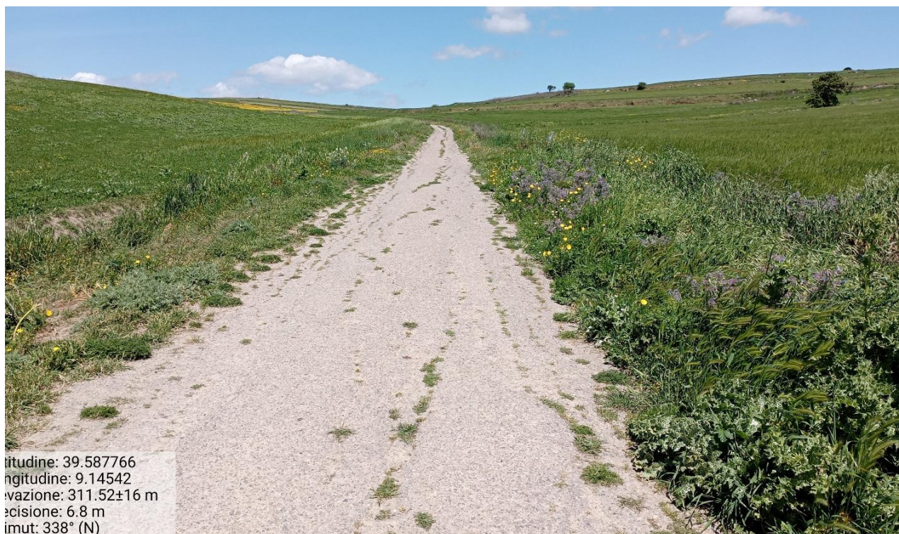
Figura 5.9- Tratturo di viabilità esistente di accesso all'asse della piazzola AG07 (direzione nord)
