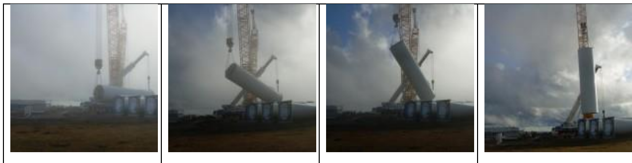
Figura 5.36 – Schema delle fasi di sollevamento dei componenti dell'aerogeneratore (Fonte sito web http://www.windfarmbop.com/ )
