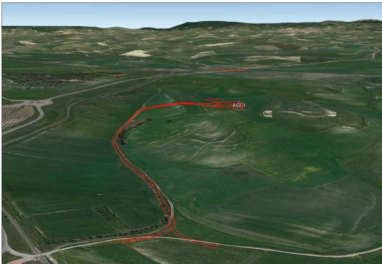
Figura 5.18 – Percorso di nuova realizzazione di accesso alla postazione eolica AG01 (vista verso nord-est)
