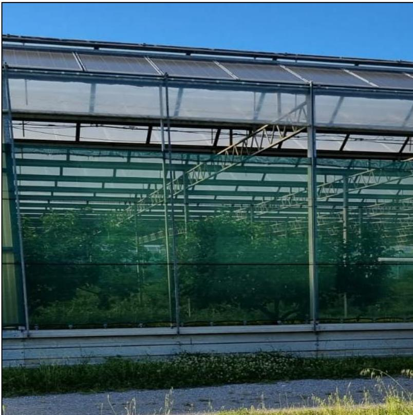
Figura 27: Foto delle serre agrivoltaiche dell'impianto di Scalea (CS), all'interno delle quali si coltivano agrumi (cedri e limoni). Si evidenzia la tipologia di rete frangivento che verrà utilizzata per i tracker dell'impianto agrivoltaico
