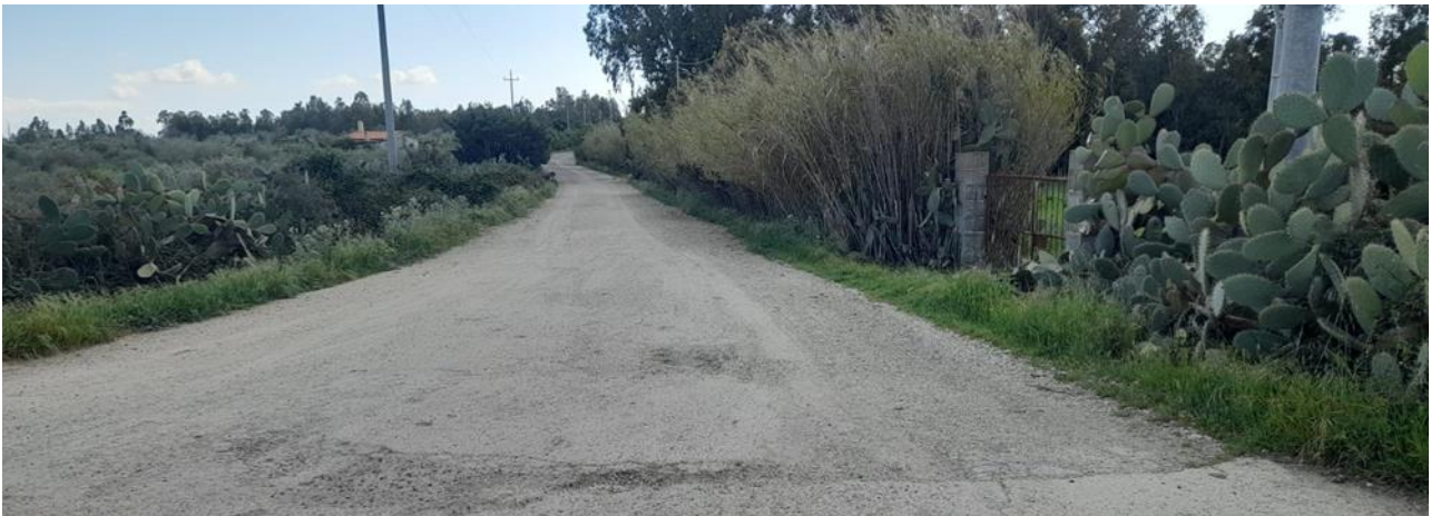
Figura 4: Imbocco strada larghezza 7,7 m
