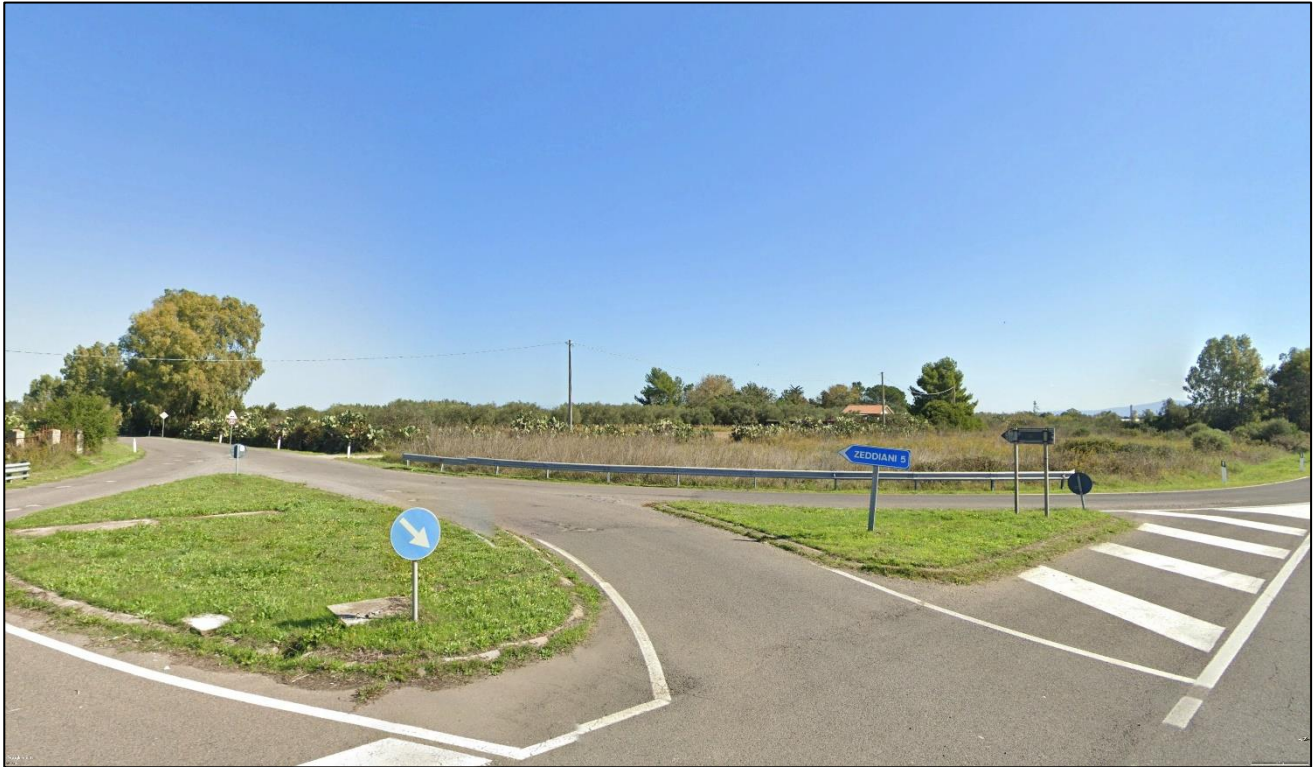
Figura 61: Immagine catturata dal PVC11_Nurachi2, sull'incrocio tra strada di impianto a valenza paesaggistica SP292 e strada di impianto a valenza paesaggistica di fruizione turistica SP1, in Area dichiarata di notevole interesse pubblico
