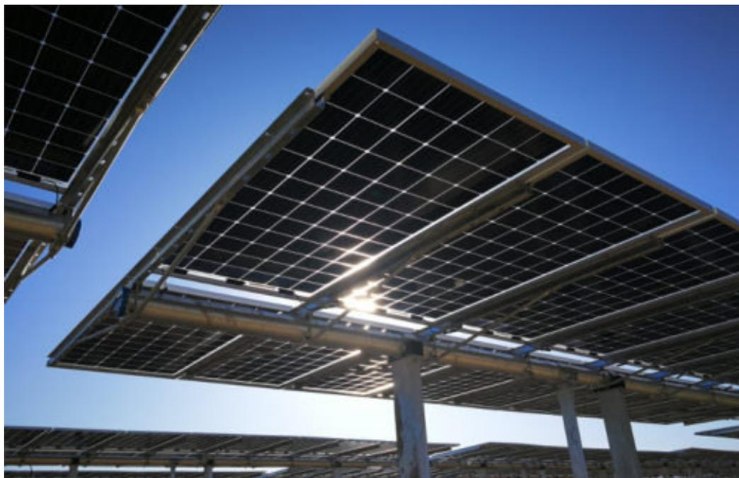
Figura 3.3 - Esempio di struttura a tracker monoassiale 2p
