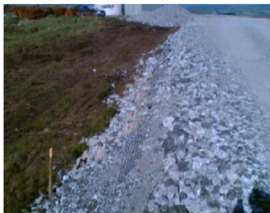
Figura 15: Superficie stradale in misto stabilizzato e drenaggio
