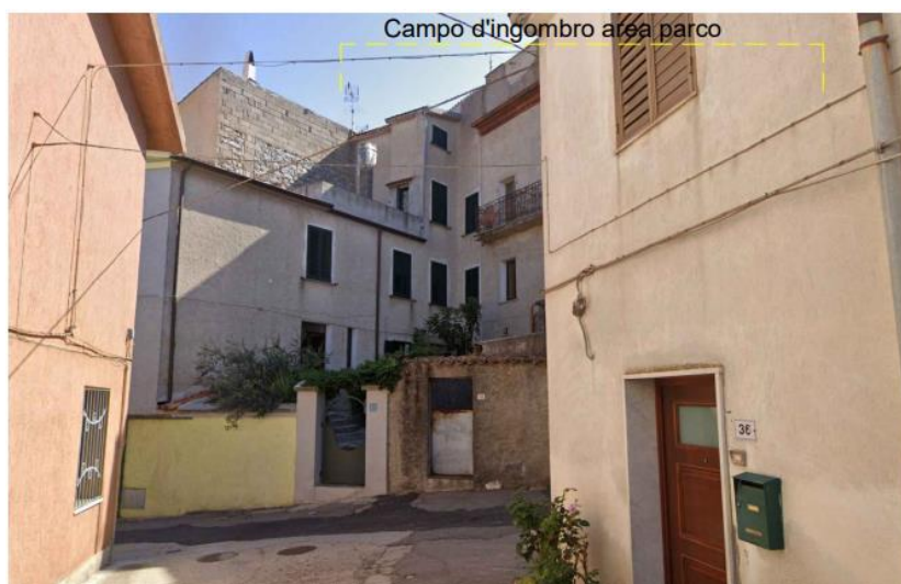
Figura 19. F04 - Ante e Post Operam - Edificio di Civile Abitazione (Comune di Nule)
