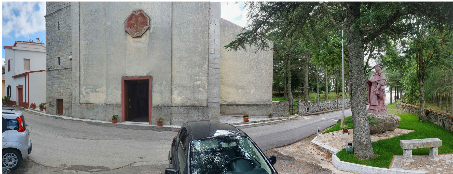
F06 - Ante e Post Operam - OS02 Vista dalla Chiesa di Sant'Angelo Martire (Comune di Osidda)
