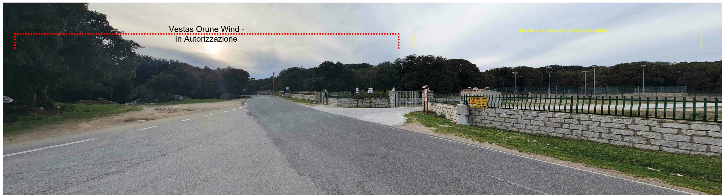
F24 - Ante e Post Operam - Vista dalla SS389 (Comune di Orune)
