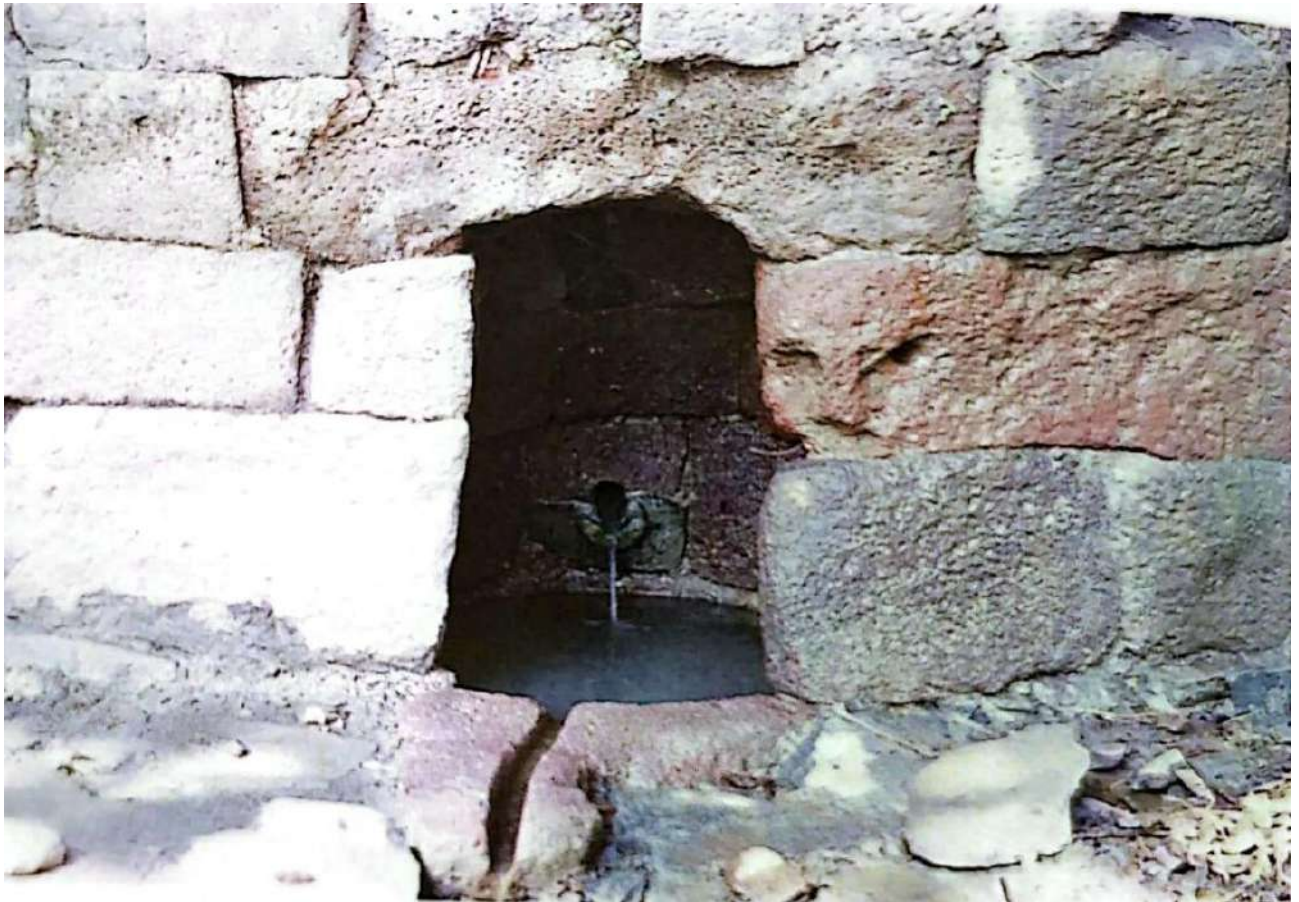
Figura 8: particolare area pozzo sacro Su Tempiesu, Orune (foto da: M. A. Fadda, 1988)
