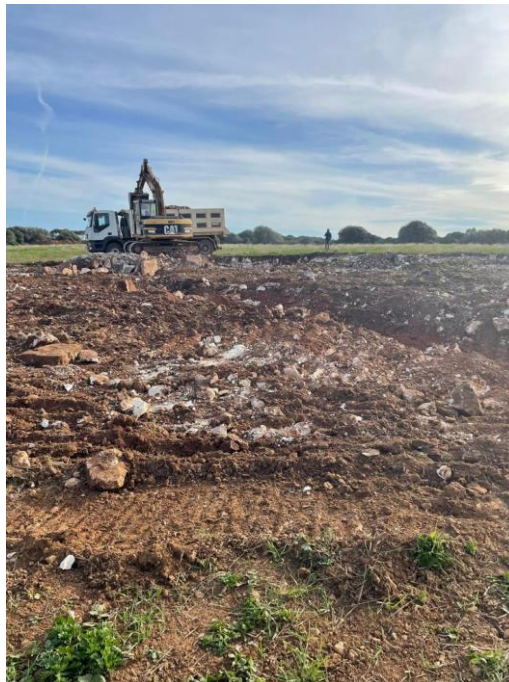
Figura 21 - Scavi di sbancamento
