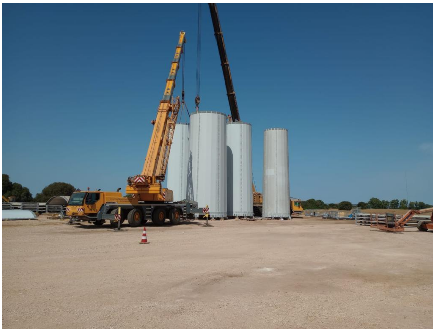
Figura 26 - Conci della torre posizionati sulla piazzola
