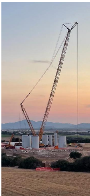
Figura 27 - Installazione gru principale
