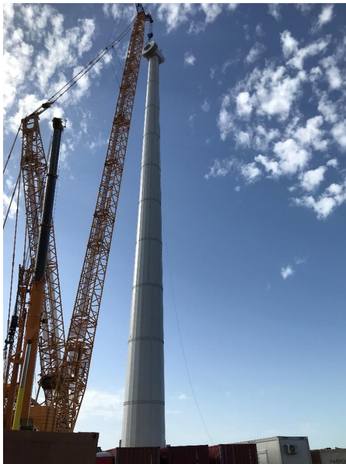
Figura 29 – Installazione della navicella
