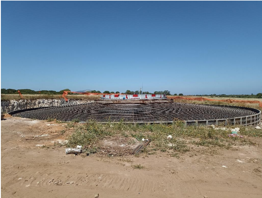
Figura 24 - Armatura della fondazione
