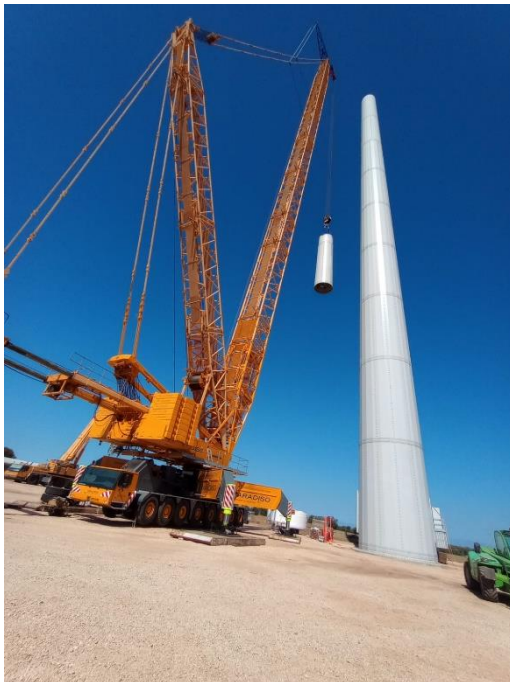
Figura 28 - Montaggio torre
