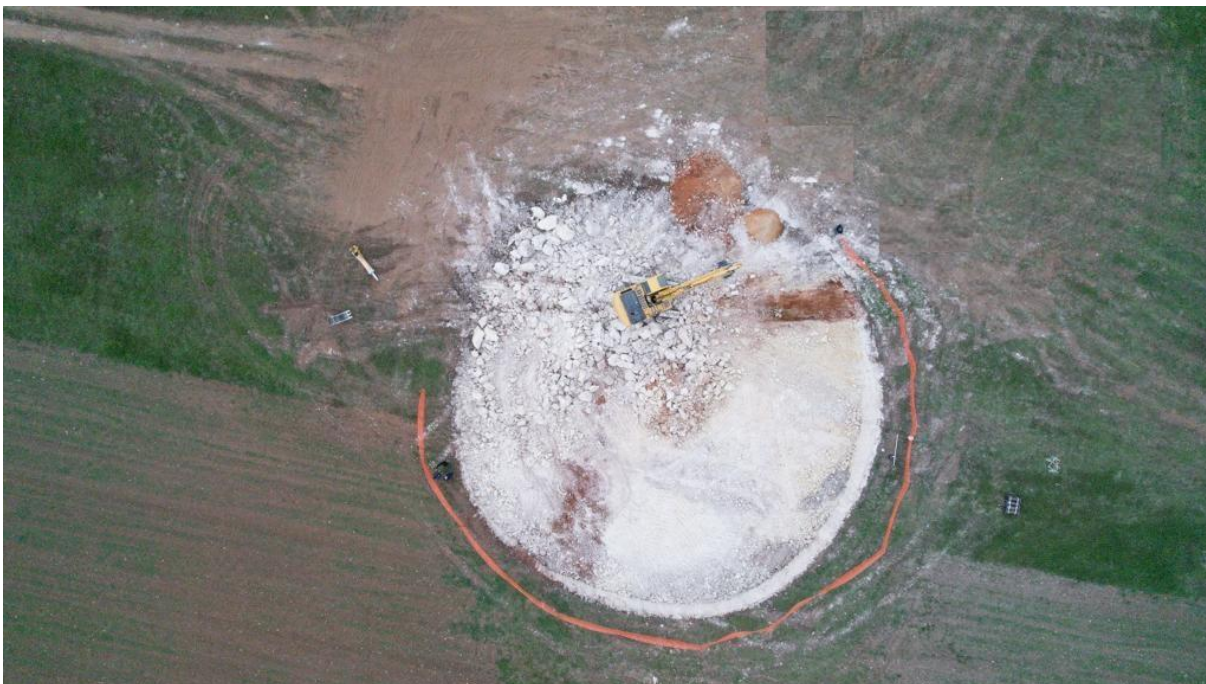
Figura 22 - Scavi di fondazione
