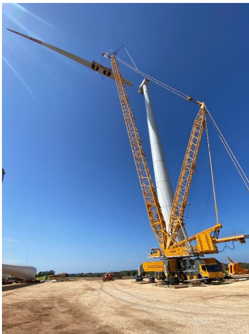
Figura 30 - Montaggio delle pale
