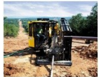
PERFORAZIONI MEDIANTE LA NO-DIG
