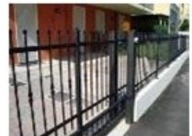
RECINZIONE E OPERE IN FERRO
